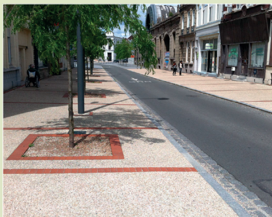
Requalification de la rue de la gare en voie bus et liaison piétonne avec le centre-ville © Cerema/DTer Nord-Picardie
