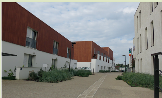
Espace public structurant de l'écoquartier © Dreal Pays de la Loire/Emmanuel Rault
