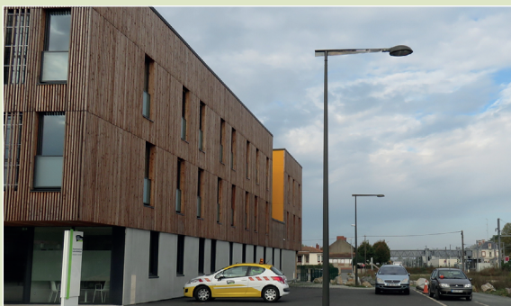
Locaux de la délégation Vignoble du Département de Loire-Atlantique, et la gare au fond © Dreal Pays de la Loire/Emmanuel Rault
