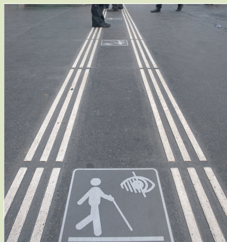
Signalétique accessibilité, bande podotactile © Bernard Suard/MEDDE-MLETR
