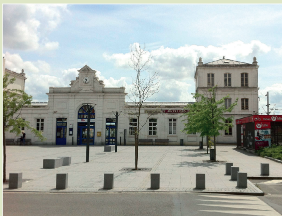
Parvis de la gare vue de face © Cerema/DTer Nord-Picardie
