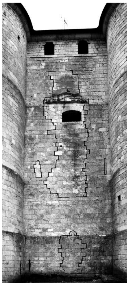
Fig. 23 - Vernon, fort des Tourelles, face sud-est de la tour : visualisation des restaurations de 1760-1765.
