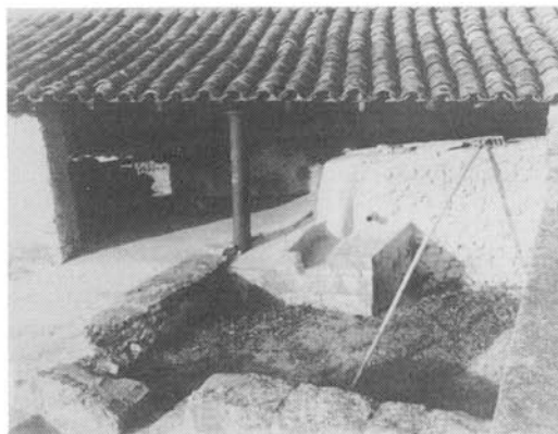
Bourlau de l'atelier de la Grande Cheminée.
