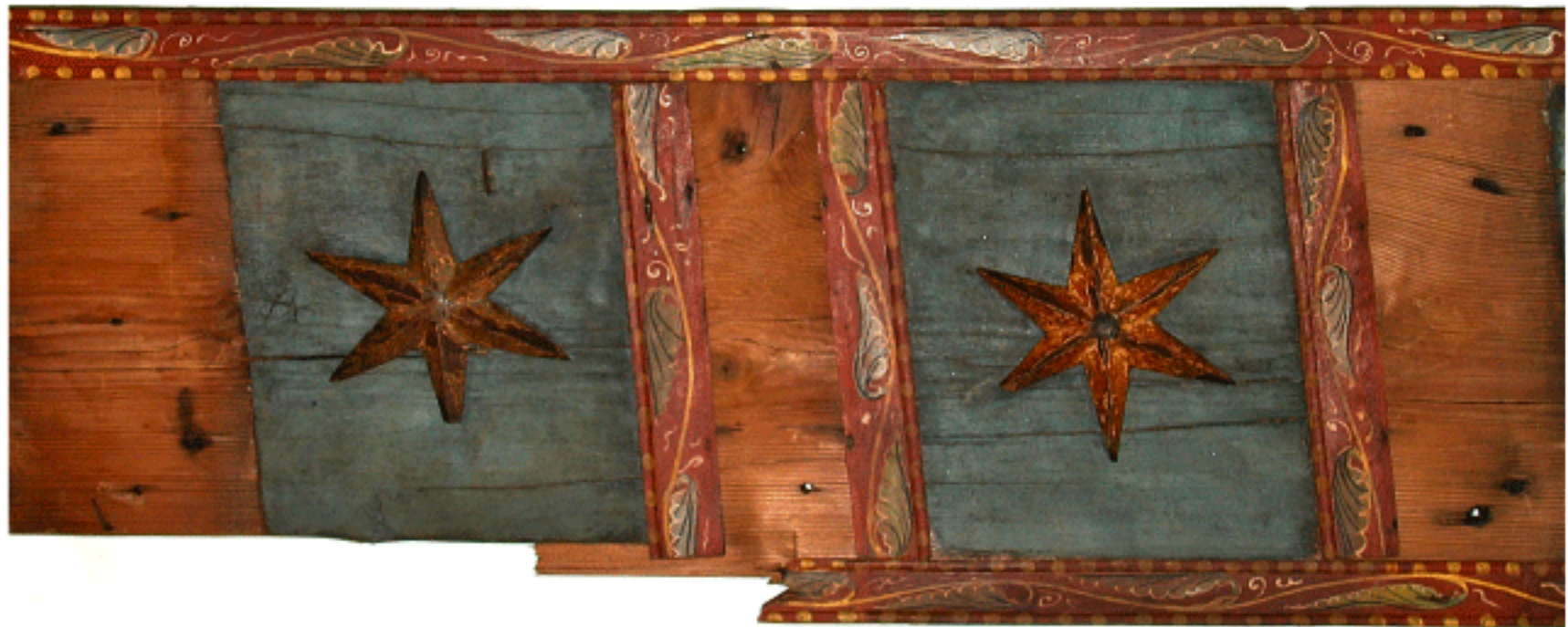
Fig. 64 : La principale lame de plancher après restauration et remise en place de couvre-joints et de baguettes de bordure des compartiments étoilés. Vues générale et détail (clichés P. Maritoux, LA3M).
