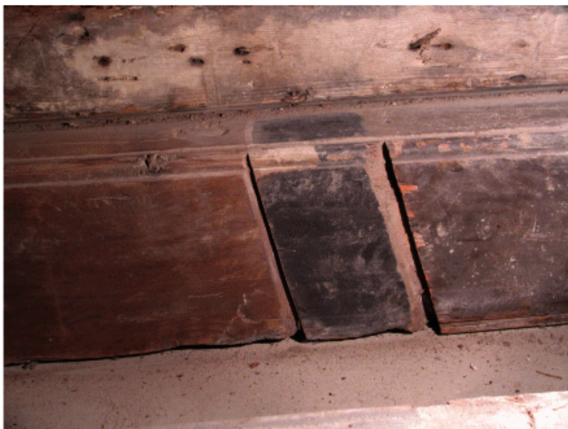
Fig. 24 : Éléments de polychromies, rouge ou noire, visibles entre les rainures d'insertion des closoirs constitutifs des deux états chronologiques du plafond. La solive de la vue supérieure montre aussi au passage de la poutre une couche orangée encore sous-jacente, peut-être une couche au minium (clichés P. Maritiaux, LA3M).
