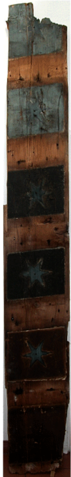
Fig. 40 : Dégagement et nettoyage de la polychromie de la principale lame de plancher conservée. Les deux compartiments inférieurs sont dans leur état initial. Le premier a été badigeonné alors que l'étoile avait déjà disparue. Le second montre, à l'emplacement de celle-ci, l'applat bleu de la couche originale. Dans les deux compartiments médians, la polychromie est dégagée mais reste complètement imprégnée et assombrie par la suie. Les deux compartiments supérieurs montrent la couche picturale dégagée et nettoyée (cliché P. Maritiaux, LA3M).
