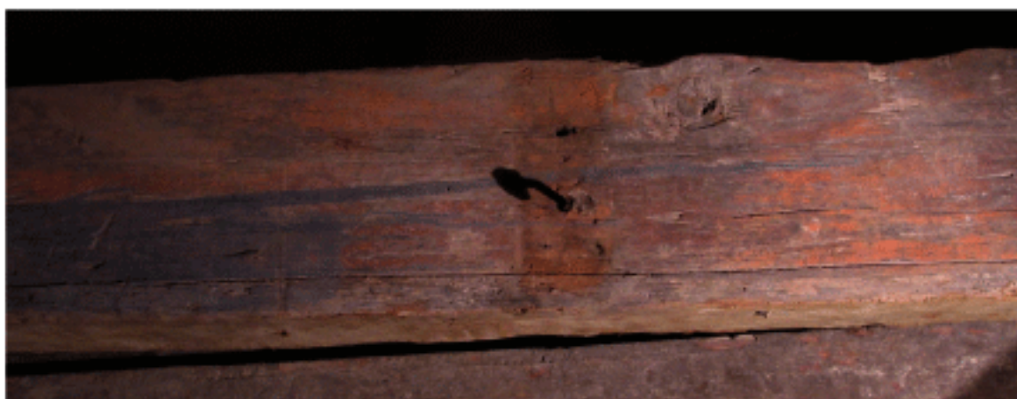
Fig. 8 : Solive de rive. Dépouvue de boudin d'angle, elle conserve l'empreinte et le clou de fixation d'un coin servant à la mise en place des bandeaux prolongeant le registre des closoirs. La surface présente une couche continue rouge usée mais aussi des traces superposées de bleu.
