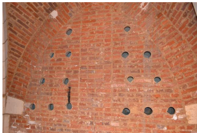
Figure 1: Mur ouest du caveau
