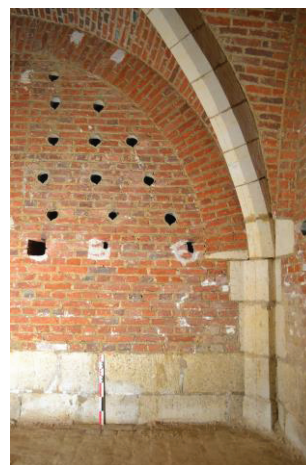
Figure 2: Moitié ouest du mur sud
