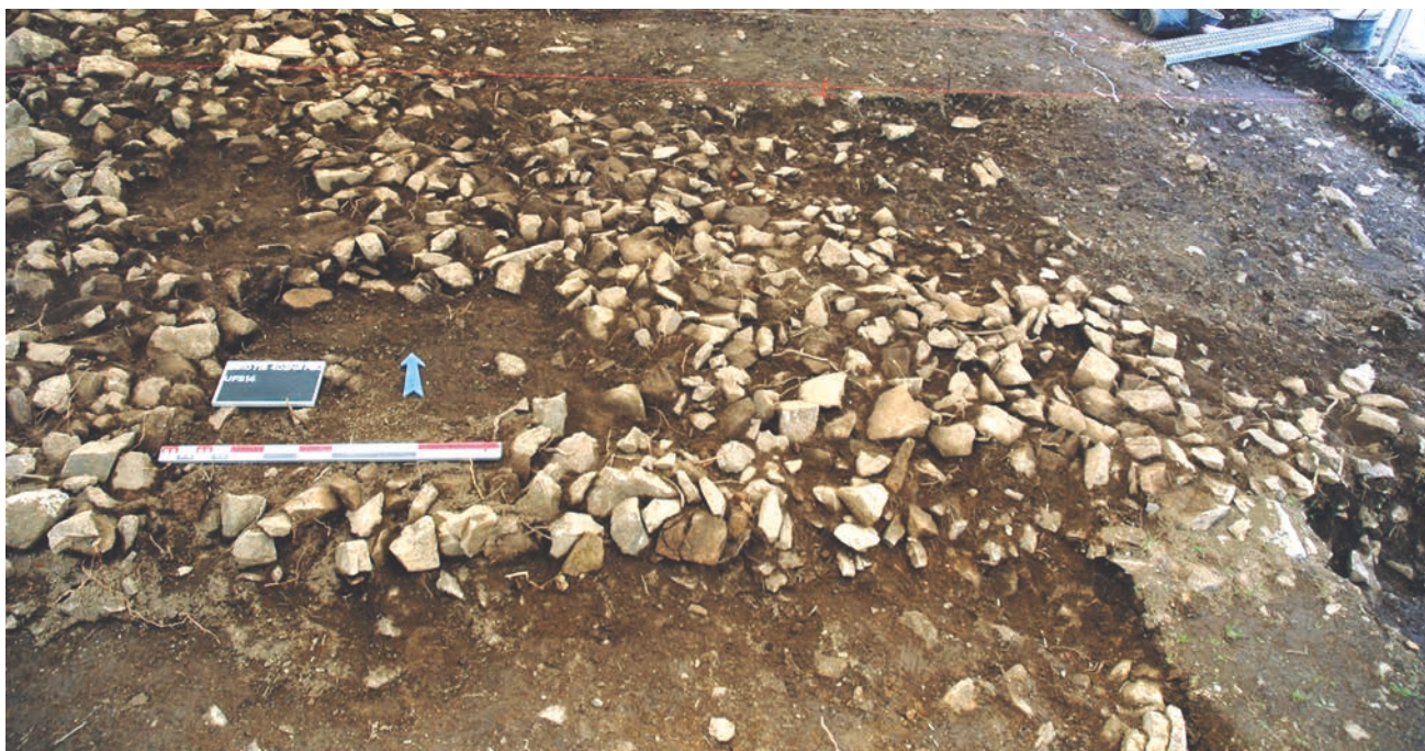
5. BibRACTE, Mont Beuvray. Le Theurot de la Roche. La démolition du mur M [10/72]. Vue nord (cliché IASA).
