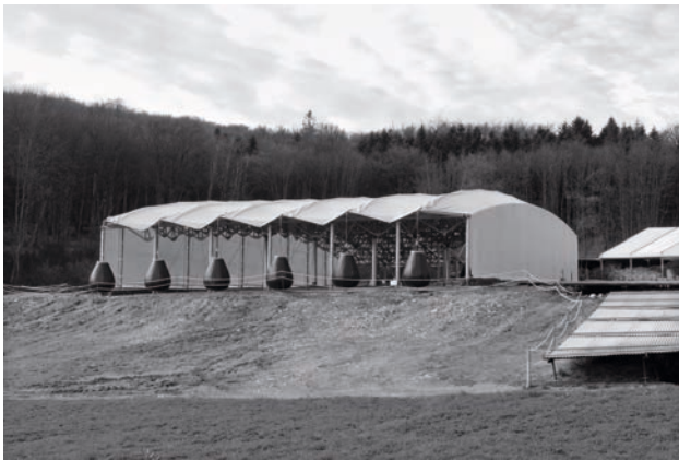
8. Les vestiges du secteur de la basilique césarienne à la Pâturage du Couvent, avec leur nouvelle protection et les passerelles de visite.
