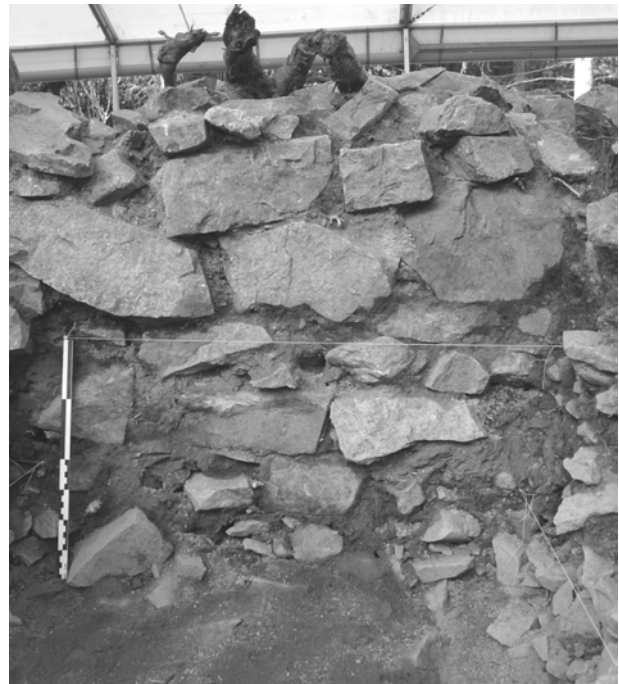
6. Bibracte, Mont Beuvray. Le Theurot de la Roche. Photo des fondations et de l'élévation du mur M[70].
