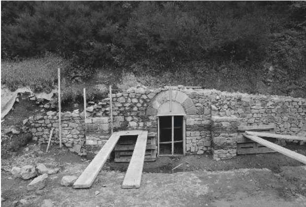
Bibracte, Mont Beuvray. Restitution de la voûte du captage de la source de PCI.
