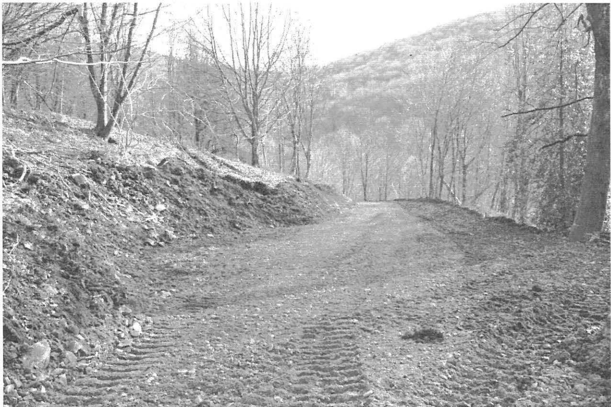
2. Recherches autour du Mont Beuvray. Vue de la voie forestière de l'Échenault, après travaux. À gauche de la photo, bas du secteur en friche.
