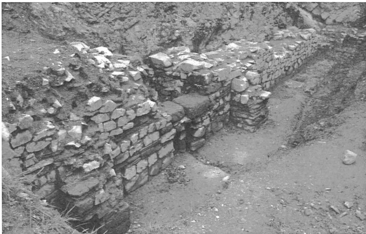
7. Bibracte, Mont Beuvray. Travaux de mise en valeur de la domus PC 1. Aménagement du mur antique dans le mur de clôture est, remanié par J.-G. Bulliot
