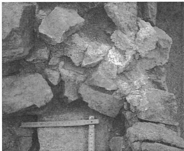
5. Bibracte, Mont Beuvray. Étude préliminaire des liants de maçonnerie. Volume de mortier de chaux clair (types MS1 et MS2) dans le mur [1036].
