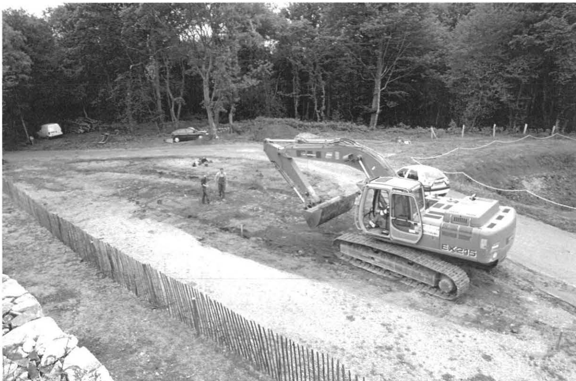
Déplacement de la route à la Porte du Rebout, juillet 2002. Vue générale vers le sud du chantier en cours de décapage.
