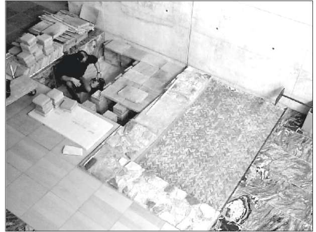
1. Musée de Bibracte. Mise en place dans l'exposition permanente d'un sol en opus spicatum et d'un hypocauste, procédés de dallage et de chauffage au sol retrouvés dans des maisons de Bibracte datées du 1 er s. av. J.-C.
