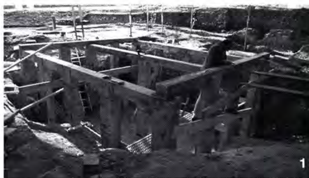
2. Deux étapes de la reconstruction de la cave à ossature de bois [585] fouillée par l'université de Bologne à la Pâturage du Couvent.
