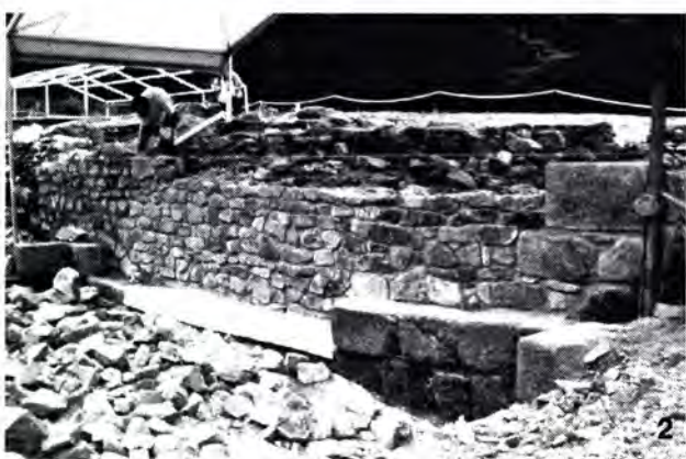
3. Maçonneries de l'état 5 de la domus PC 1 au Parc aux Chevaux : 1, avant restauration; 2, après restauration.
