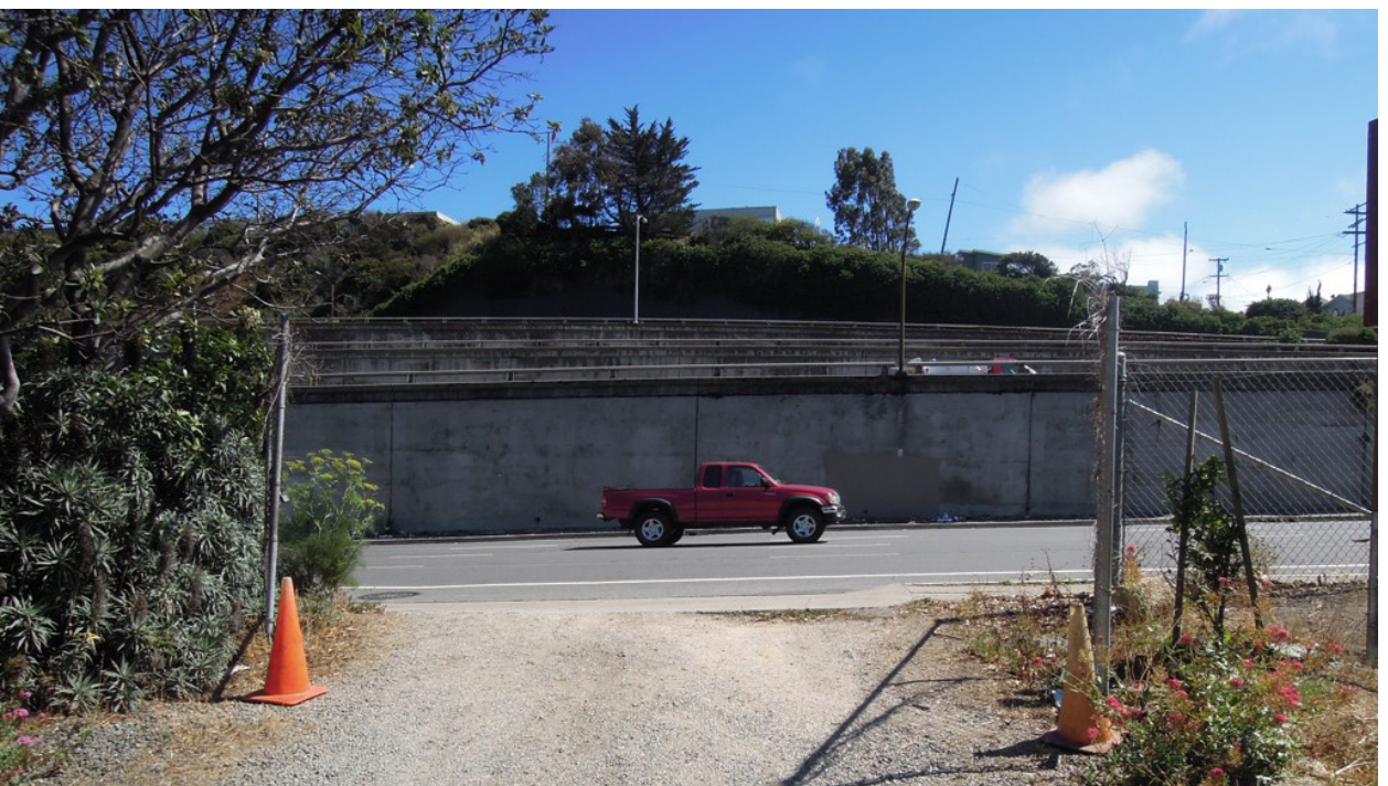
Entrée des jardins en regardant vers les voies, le niveau atteint et dépasse 70 dB(A)
