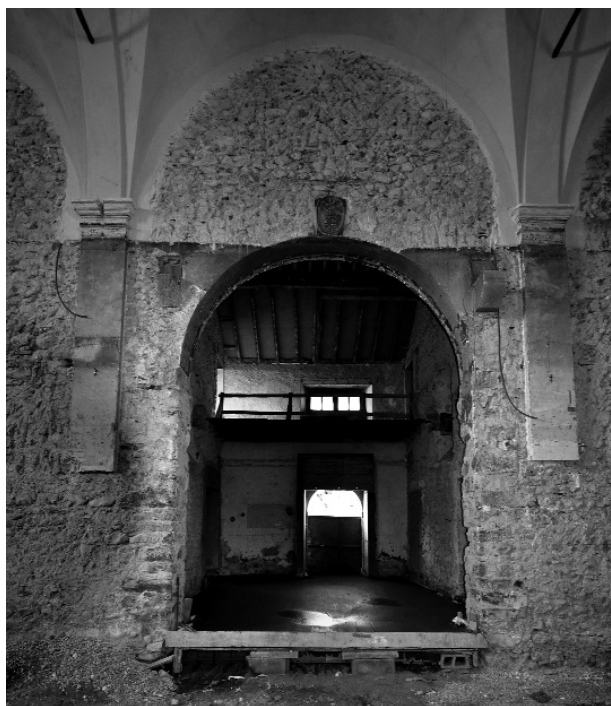
Fig. 5 : Chapelle latérale nord, vue depuis la nef, cliché Romain Aimé.
