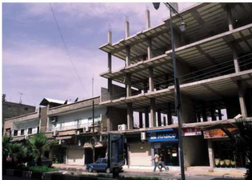
Figure n° 1 : La rue principale de Jeramana en 2008 : immeuble en construction à côté d'une des dernières habitations basses de la ville.
