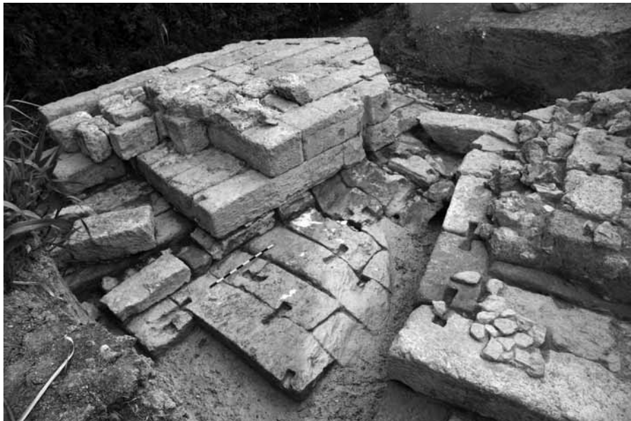
Figure 15. Vue du pont-barrage sur le Nahr ed-Delbé depuis le sud-ouest (pile centrale à gauche ; massif d'ancrage à droite) (V. M. © Mission de Ras Shamra).
