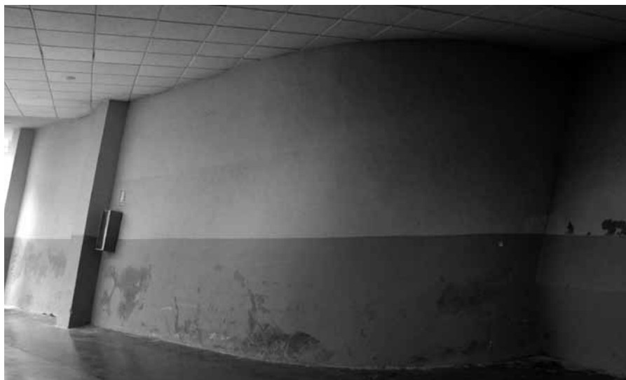
Ceuta - le bastion désormais inclus dans les fondations du marché de la ville.
