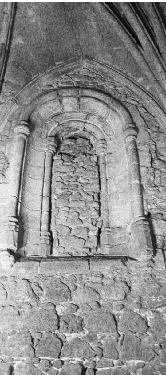
Safi, fenêtre (actuellement fermée) de l'ancien transept de la cathédrale. A remarquer les nervures de la voûte.
