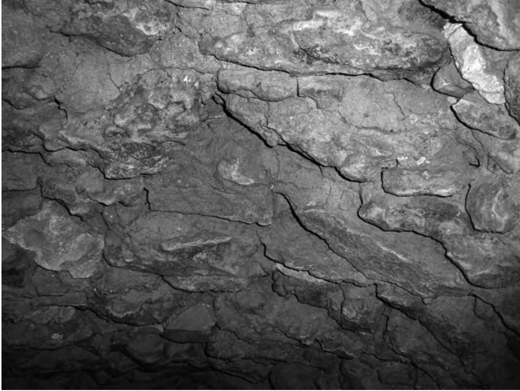
Fig. 17 – Détail des pierres sèches constituant la partie construite du puits du puits 3150 du Bâtiment B, chantier « Grand-rue » (© Mission de Ras Shamra, cliché V. Matoïan).
