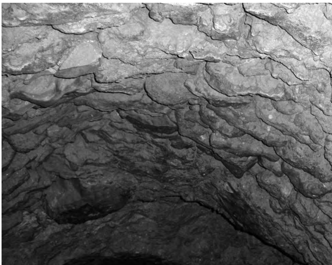
Fig. 16 – Partie construite en pierres sèches du puits 3150 du Bâtiment B, chantier « Grand-rue » (© Mission de Ras Shamra).
