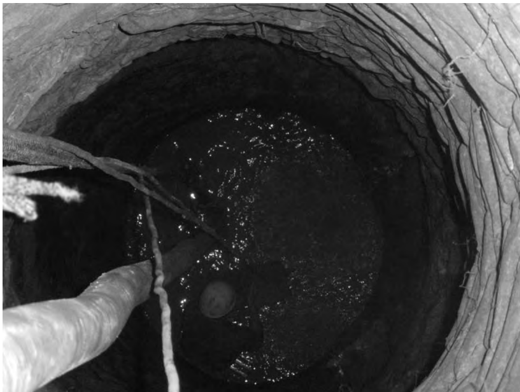
Fig. 10 – Travail au fond du puits 3150 du Bâtiment B, chantier « Grand-rue » (© Mission de Ras Shamra, cliché B. Geyer).
