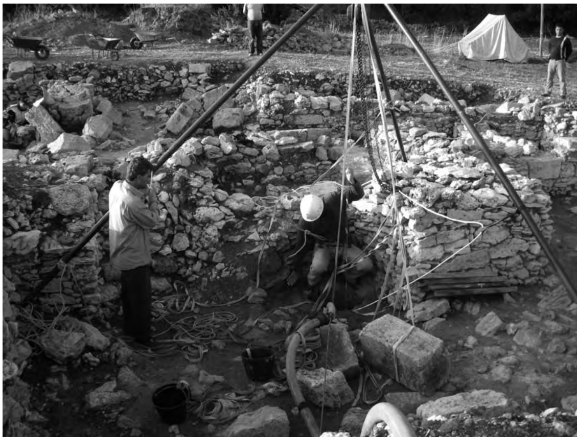
Fig. 9 – Aménagement permettant la fouille du puits 3150 du Bâtiment B, chantier « Grand-rue » (© Mission de Ras Shamra, cliché B. Geyer).
