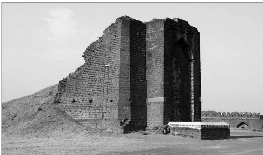
◀ Fig. 15 : Tour à eau de Bidar (Kanataka ; cl. N. M.)
