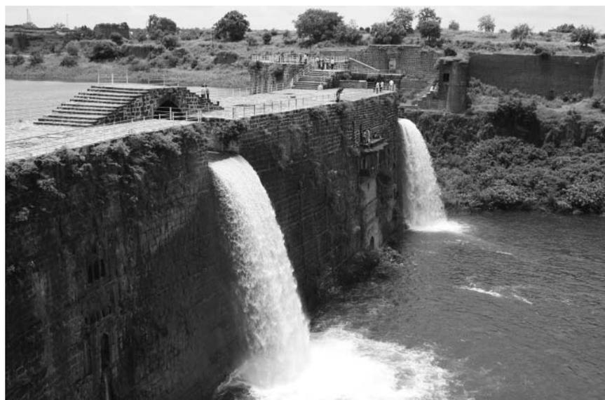
le lac de retenue englobe le méandre de la rivière jusqu'à la partie ouest du *naya qilah*, (c'est-à-dire une aire de 82 569 m<sup>2</sup> en moyenne de l'étiage annuel), alors le lac fournit un total de 859 m<sup>3</sup> d'eau (sans compter l'apport journalier de la rivière d'un côté et l'évaporation de l'autre).
