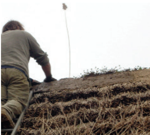
Fig. 238 : fabrication du faîtage en torchis et plantation de la joubarbe
