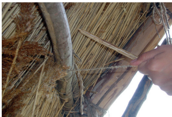
Fig. 236 et 237 : le lien en lin est passé dans l'épaisseur de la gerbe à l'aide d'une navette puis noué.
