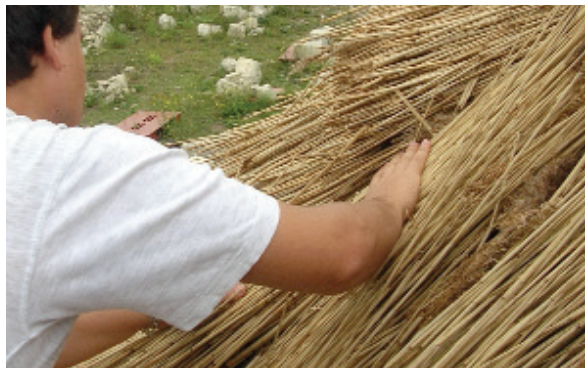
Fig. 235 a et b : étalement des gerbes de roseau - disposées en degrés
