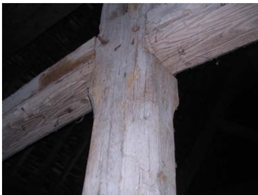
Tête et pied de poinçon. Les arêtes sont simplement chanfreinées, sans moulure ni peinture.
