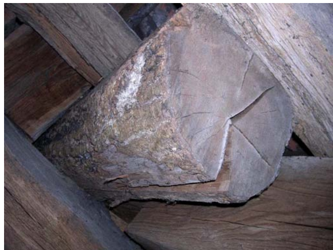
Panne taillée dans un bois de brin à peine équarri, ayant conservé son écorce
