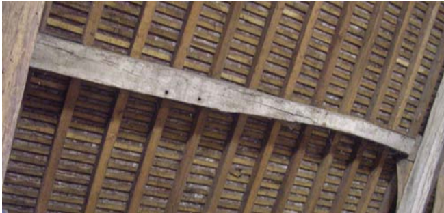
Chevron d'une ferme secondaire en réemploi, avec sa face délardée selon un profil cintré
