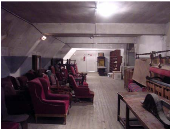
Partie inférieure de la charpente D1, masquée par les cloisonnements en plâtre
