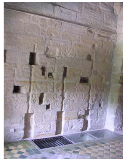
Négatifs des sièges en bois des latrines au-dessus du canal, abbaye de Maubuisson
