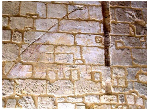
Rainure creusée dans le pignon est pour l'insertion des planchettes du lambris
