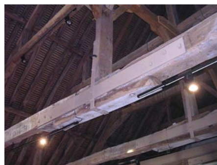
Enture des entrants maintenue par des plaques boulonnées et retenue au poinçon par un étrier
