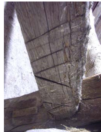
Marque d'assemblage sur un bois réemployé
