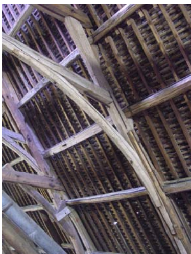
Aisseleur courbe avec ses rainures latérales pour l'insertion du lambris
