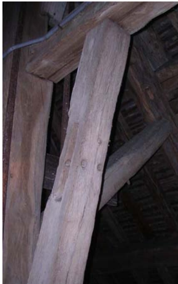
Dortoir nord, pièce mortaisée en réemploi
