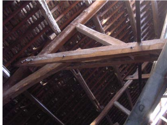
Moises en sapin, boulonnées de part et d'autre des pièces
