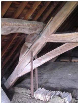
Suspente accrochée à l'arbalétrier
