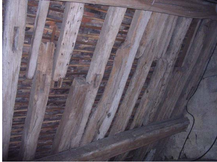
Réemploi d'un poteau mortaisé sur 2 faces, Réemploi de bois de différents types avec mortaises et tenons avec leurs marques d'assemblage
