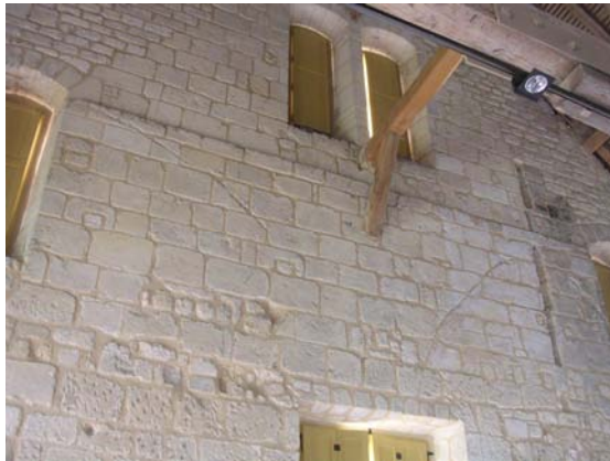
Rainure creusée dans le pignon est pour l'insertion des planchettes du lambris
