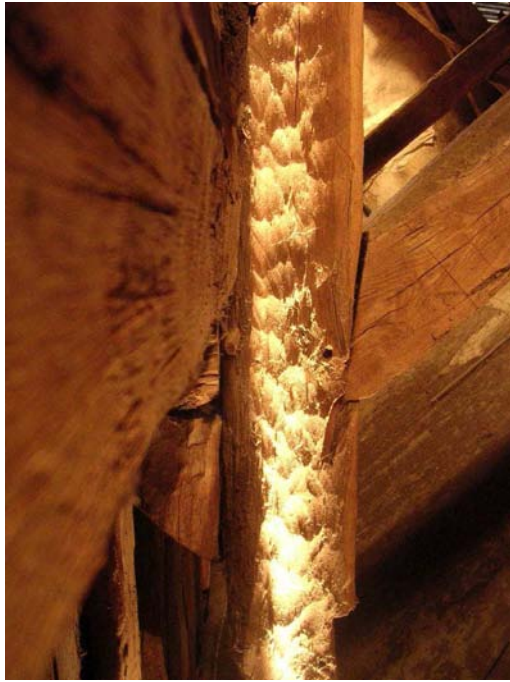
Equarrissage à la hache des bois (1710-1720) de la charpente D1
