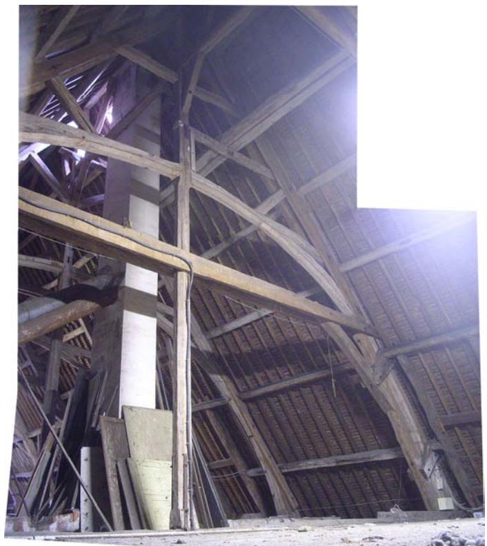
Aisseleur courbe avec ses rainures latérales pour l'insertion du lambris
