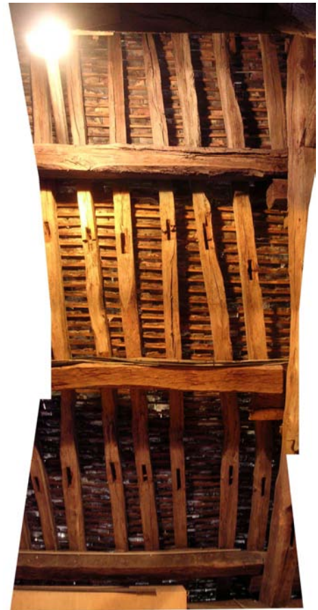
Dortoir nord, chevrons tors mortaisés en réemploi en tant que chevrons
