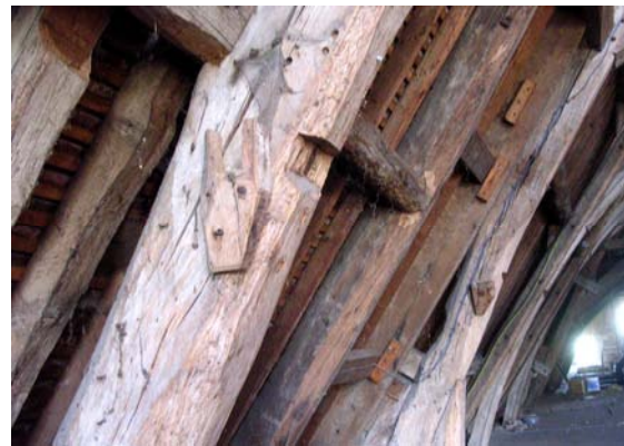
Suspentes du séchoir pour porter des perches
