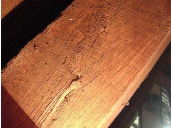
Traces de sciage de long sur un arbalétrier obtenu par débitage
