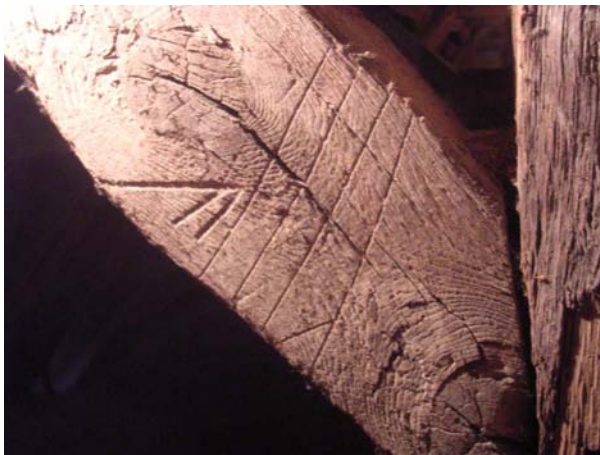
III avec contremarque de la contrefiche Est, inscrite sur un bois de réemploi, à côté d'une ancienne marque du XIII e siècle
