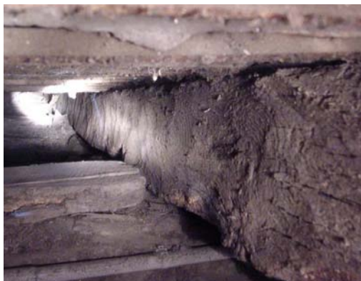
Equarrissage à la hache en vue plongeante d'un chevron
