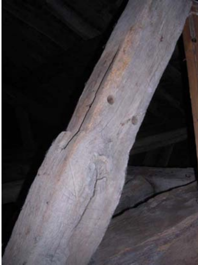
Réemploi d'un poteau mortaisé sur 2 faces, Réemploi de bois de différents types avec mortaises et tenons avec leurs marques d'assemblage
