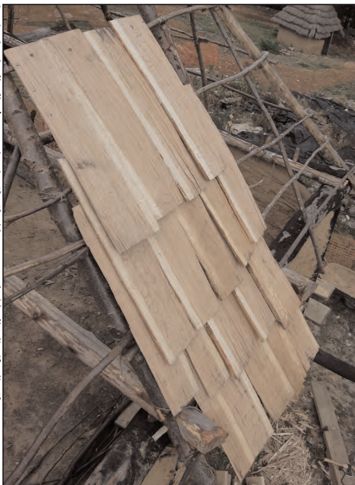
Fig. 80 : essai de pose des bardeaux
