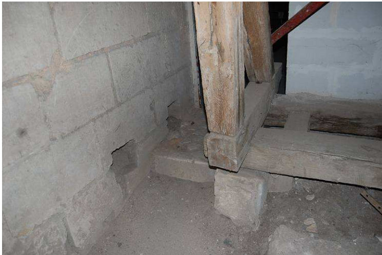
Fig. 21 : Logements dans les maçonneries de la tour du transept pour les sablières
