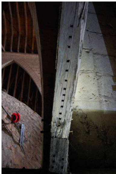
Fig. 69 : Marque à encoches carrées de la demi-ferme sud 13.
