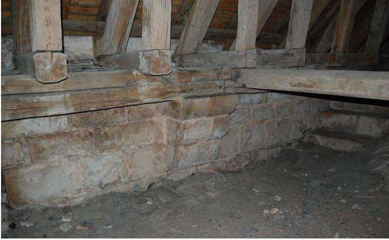
Fig. 14 : Débord des sablières internes sur des corbeaux
