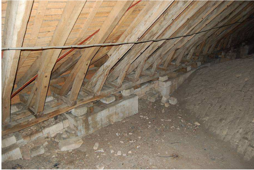
Fig. 58 : Gouttereau nord avec corniche en encorbellement entre des massifs de maçonneries. Les sablières sont tardives.
