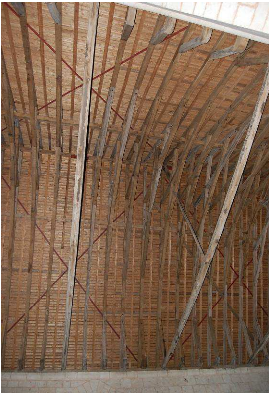
Fig. 49 : Charpente du vaisseau principal.
