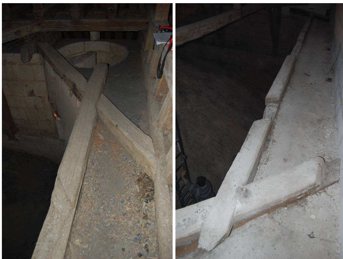
Fig. 74 : Sablières de l'ancienne flèche gothique
