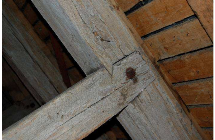
Fig. 23 : Mi-bois avec ergot des têtes d'écharpes
