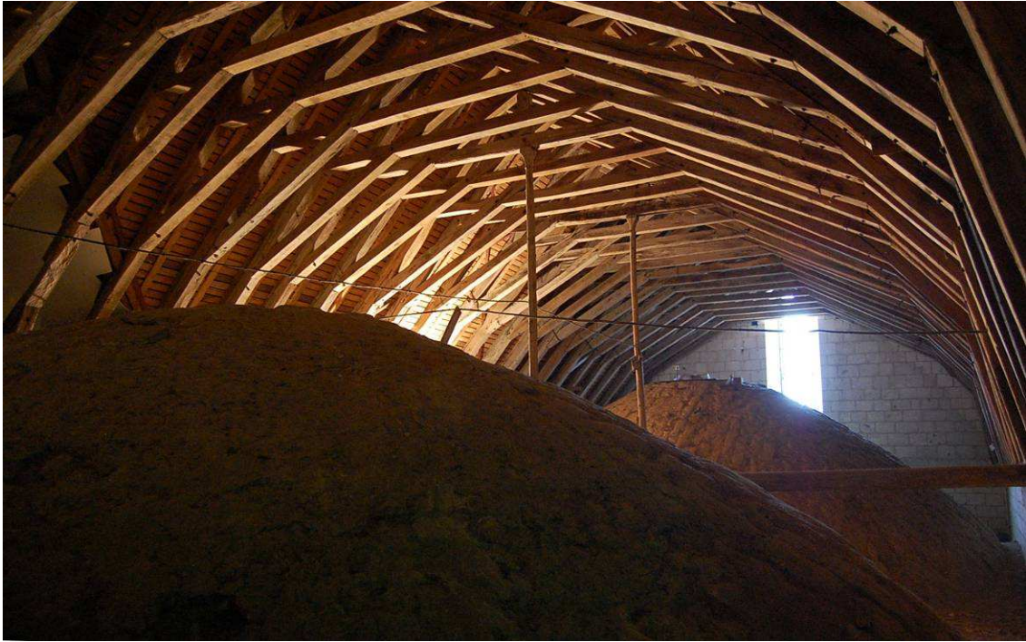
Fig. 12 Charpente du croisillon nord, vue depuis la voûte méridionale
