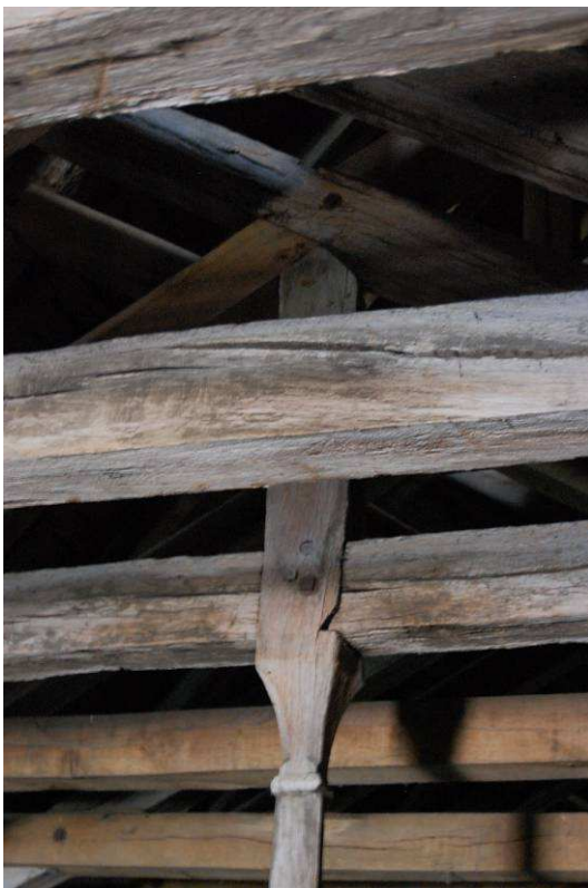
Fig. 24 : Assemblage du poinçon de F14 au faux entrain
