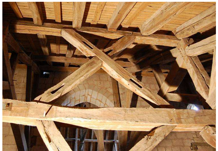
Fig. 94 : Chevrons d'origine, assemblés bout-à-bout par enture au droit de la sablière, réemployés en l'état.
