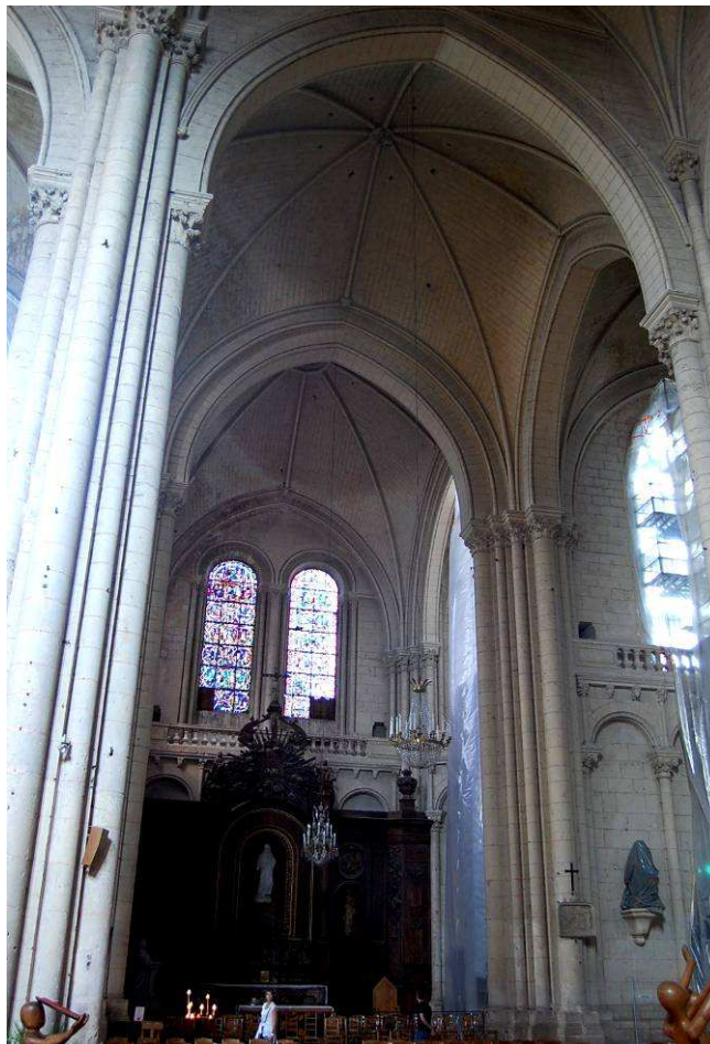
Fig. 13 : Croisillon nord et collatéral attenant.
