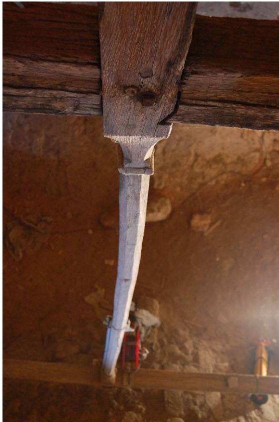
Fig. 25 : Poinçon de F18 et son assemblage en piéd
