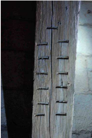
Fig. 71 : Marque à encoches rectangulaires de la demi-ferme sud 29.
