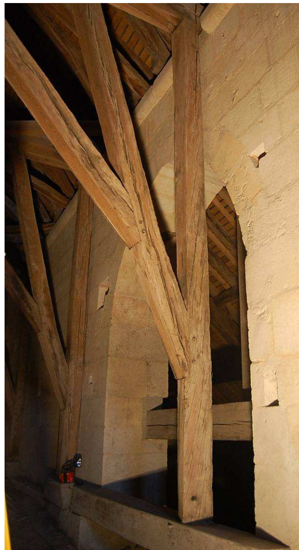
Fig. 81 : Poteau vrillé de la console sud de F7.
