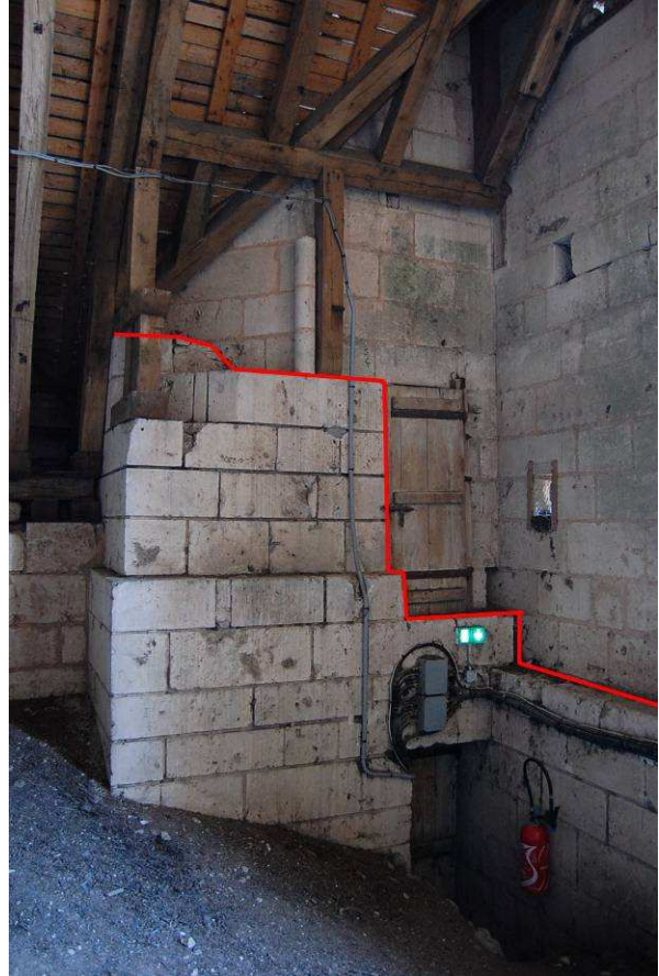
Fig. 5 : Tourelle nord-est du chœur avec en rouge l'arrêt de chantier.
