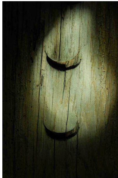
Fig. 68 : Marque à encoches en demi-lunes de la demi-ferme nord 14.
