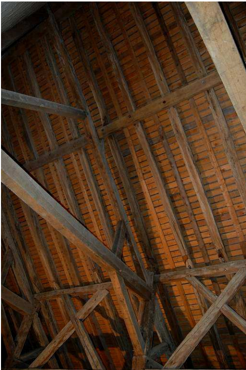
Fig. 94 : Chevrons d'origine, assemblés bout-à-bout par enture au droit de la sablière, réemployés en l'état.
