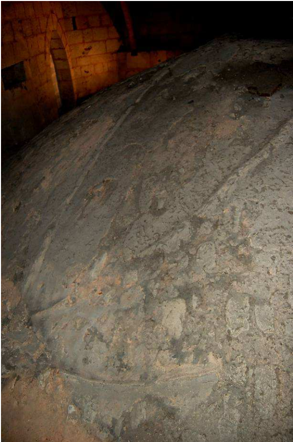
Fig. 76 : Crêtes convergentes de l'enduit vers le rein du voûtain.
