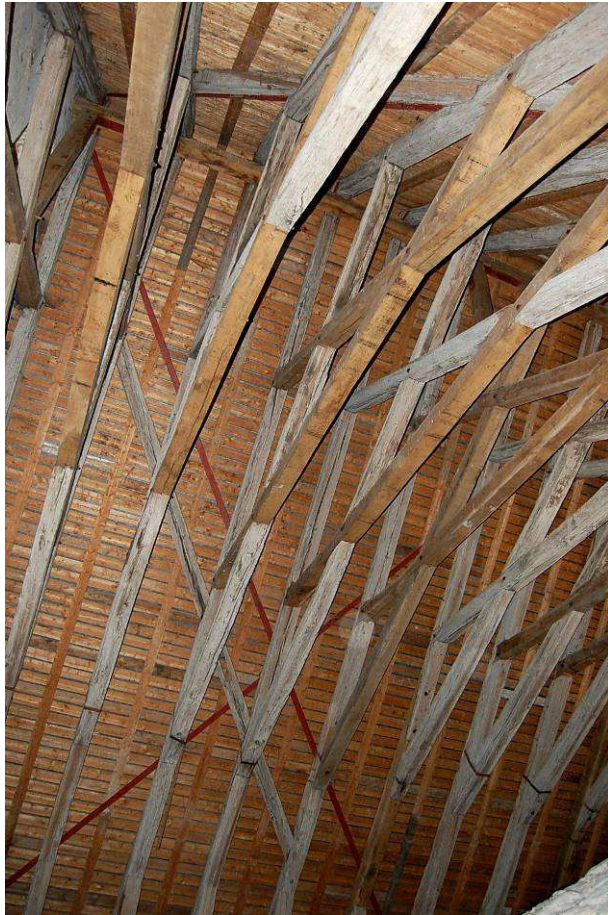
Fig. 28 : Longrine en place du contreventement des chevrons sur la travée nord
