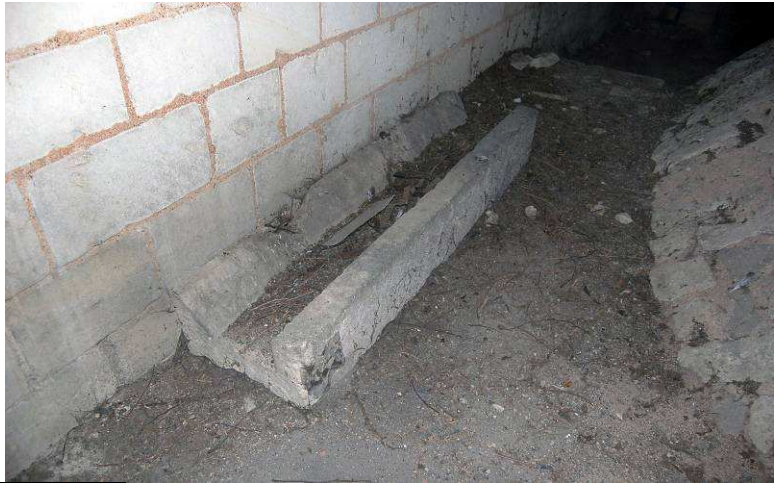
Fig. 15 : Chéneau d'origine déposé dans le comble
