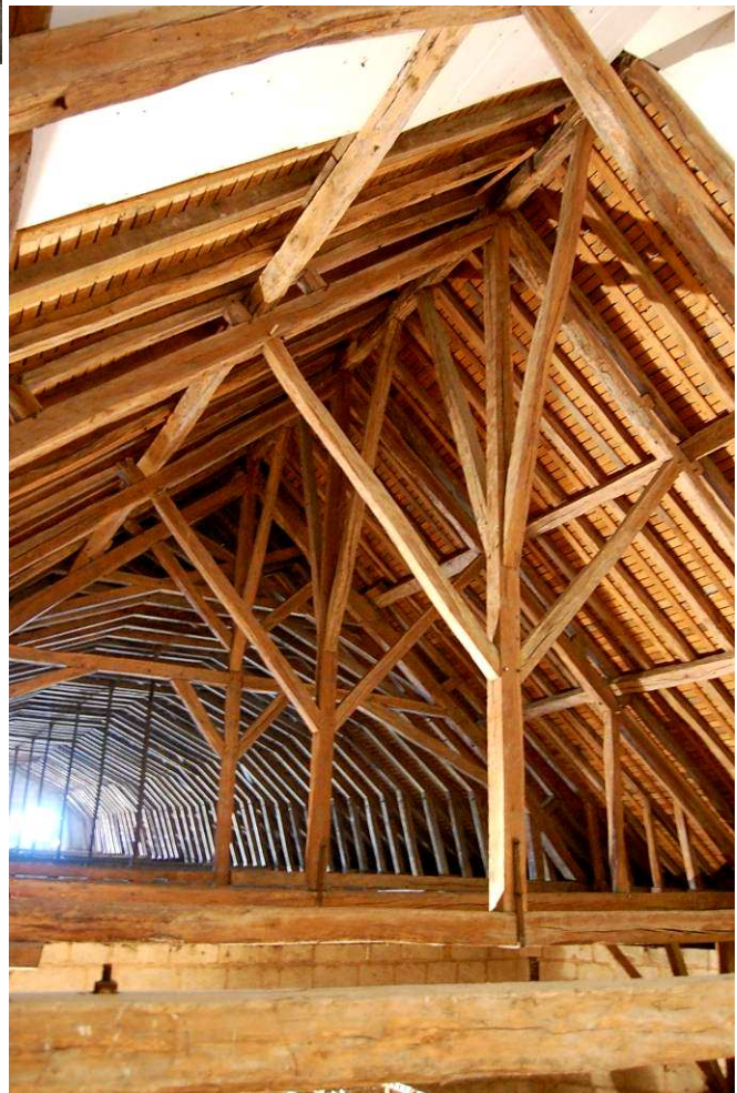
Fig. 77 : Charpente de 1770 couvrant la tour de croisée.
