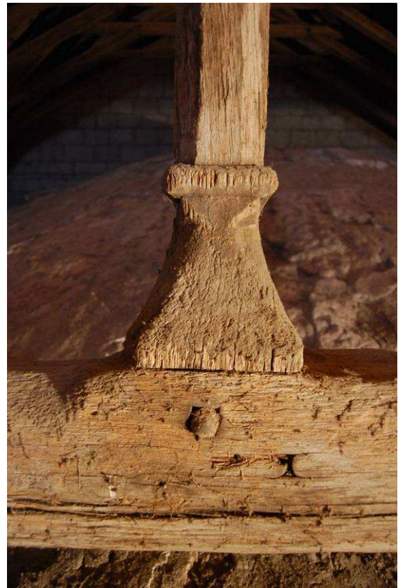
Fig. 25 : Poinçon de F18 et son assemblage en piéd
