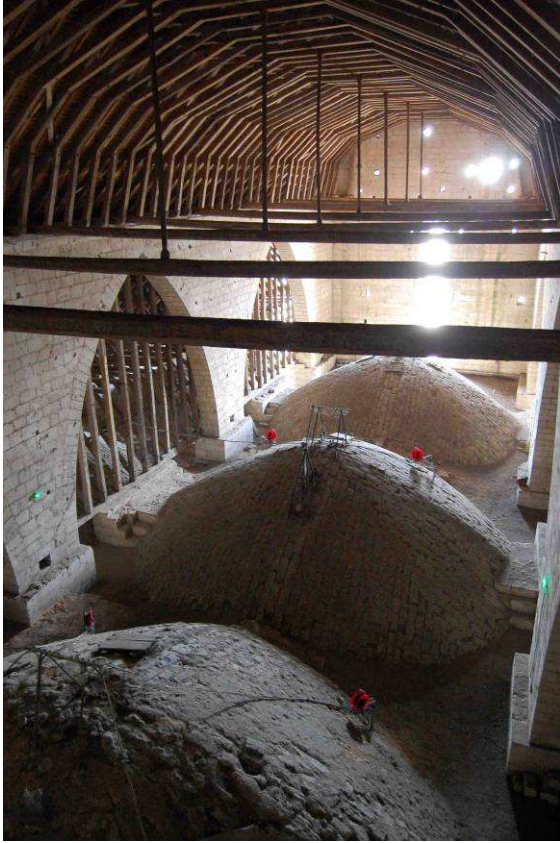
Fig. 47 : Comble du chœur.
