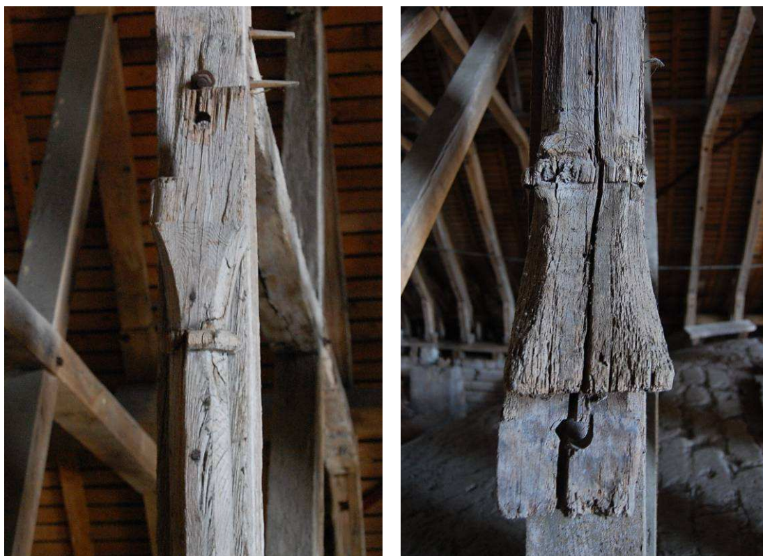
Fig. 65 : Tête et pied de poinçon, déposé après la restauration de 1983-88.
