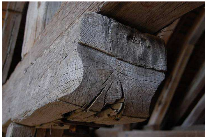
Fig. 89 : Moulure du chapeau des fermes 9 à 14.
