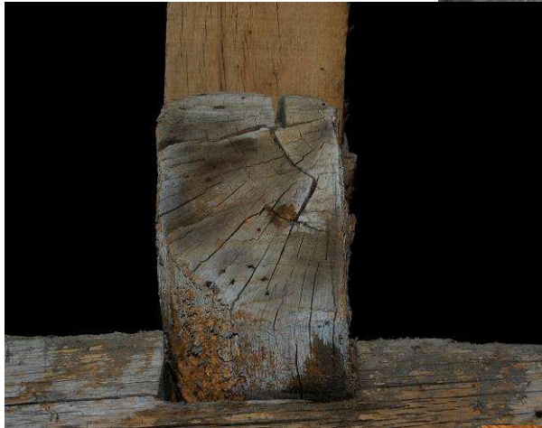
Fig. 16 : Blochet taillé dans un bois fendu en quartier
