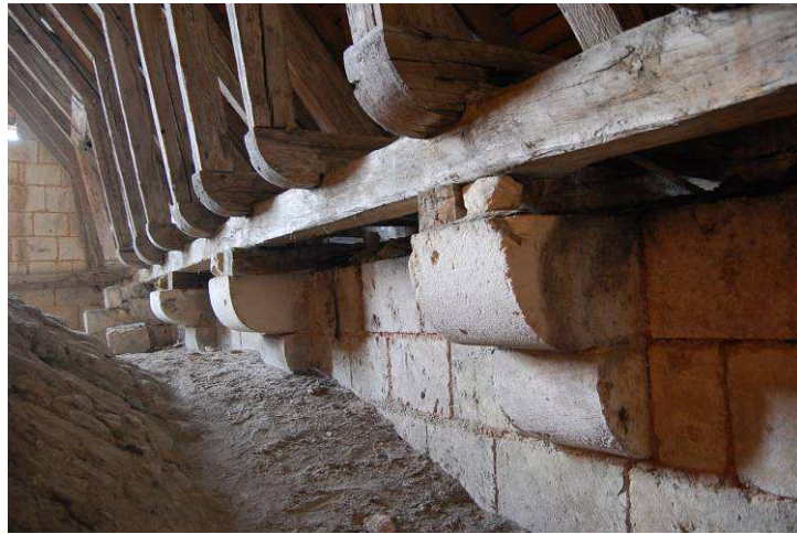
Fig. 37 : Corbeaux du muret ouest, permettant de déporter les sablières vers l'intérieur.
