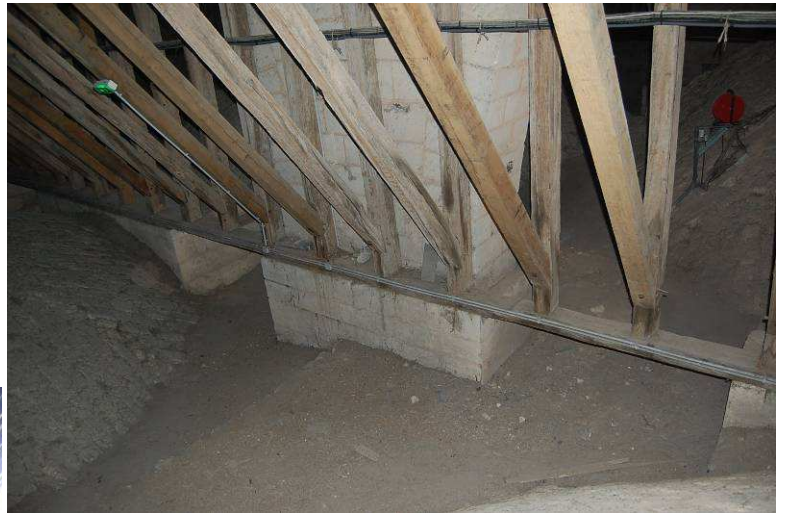
Fig. 58 : Gouttereau nord avec corniche en encorbellement entre des massifs de maçonneries. Les sablières sont tardives.
