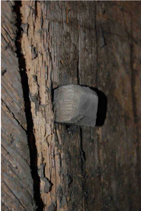
Fig. 62 : Cheville d'origine à tête aux arêtes rabattues.
