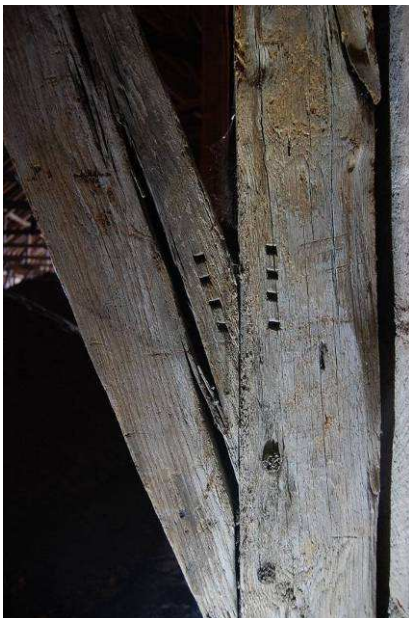
Fig. 90 : Marque à encoches sur la console nord de F4.
