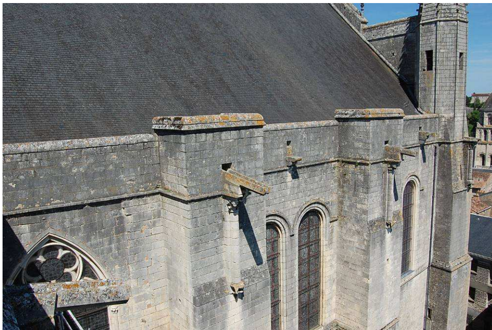
Fig. 6 : Gouttereau sud du chœur.
