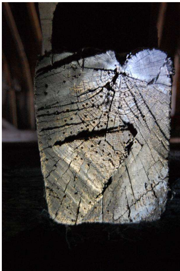
Fig. 33 : about de blochet taillé à la hache
