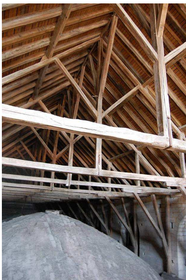
Fig. 82 : Charpente du vaisseau central de la nef
