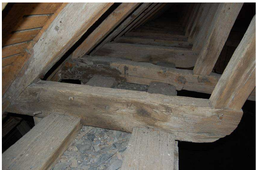
Fig. 63 : Blochet d'une ferme secondaire de la charpente du vaisseau principal.
