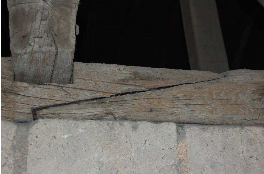
Fig. 20 : Enture oblique à talons biais des sablières
