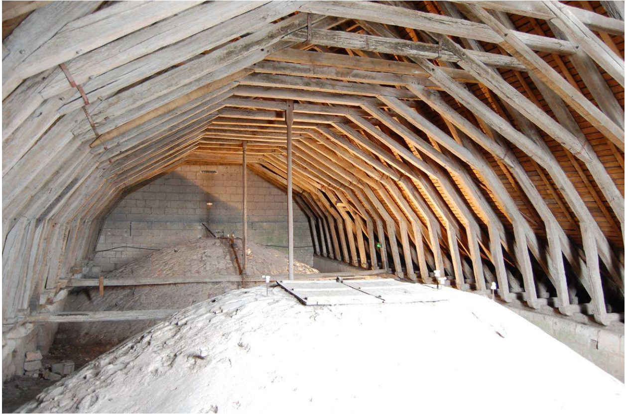
Fig. 39 : Charpente du croisillon sud, vue depuis le pignon sud.
