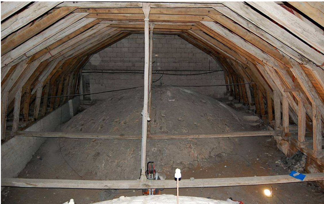
Fig. 11 : Charpente du croisillon nord, vue depuis la voûte septentrionale
