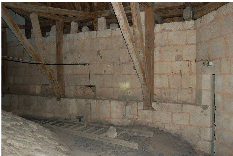
Fig. 73 : Face interne du mur nord de la tour de croisée, avec les logements pour les poutres de chaînage juste au-dessus du ressaut de maçonnerie.
