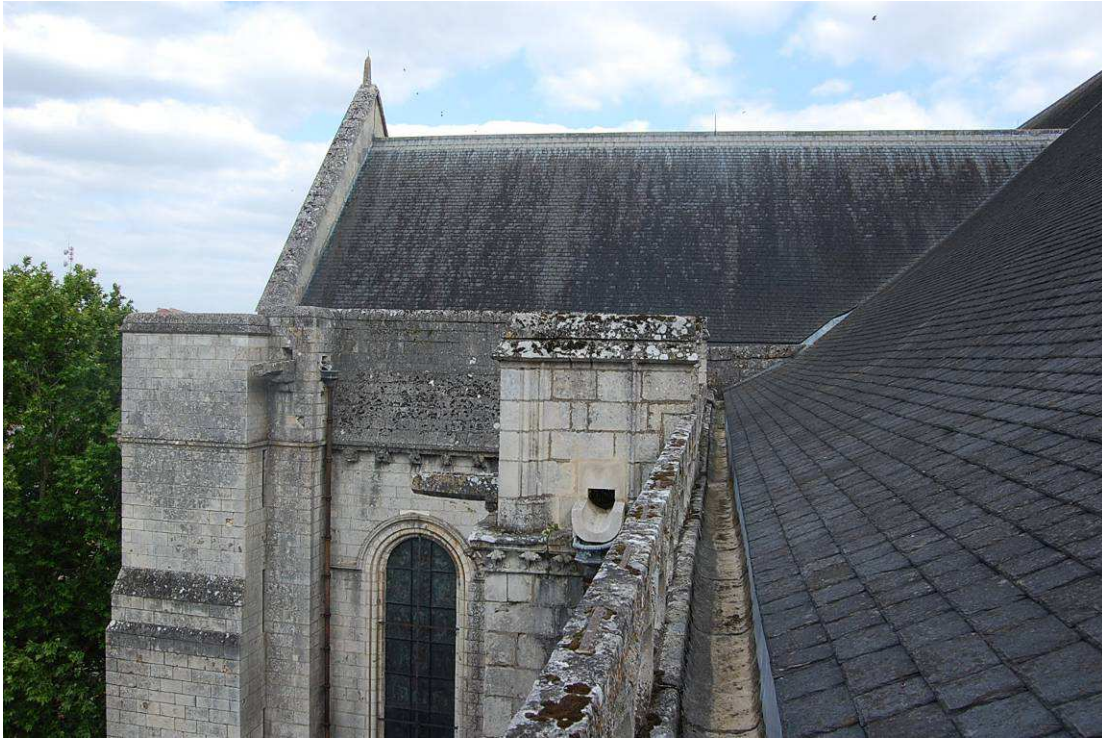
Fig. 10 : Toiture du croisillon nord du transept.
