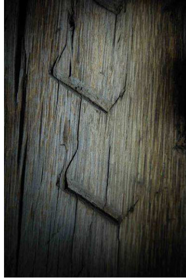
Fig. 70 : Marque à encoches en forme de crochets de la demi-ferme nord 28.
