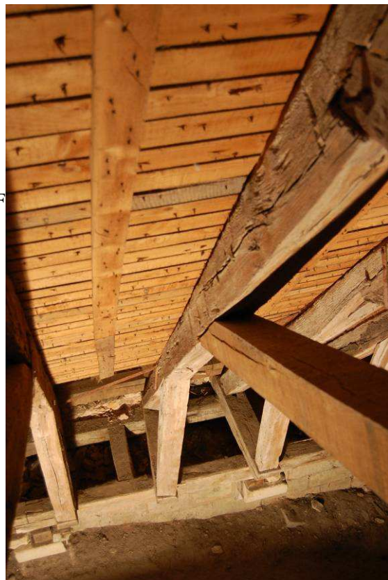
Fig. 37 : Corbeaux du muret ouest, permettant de déporter les sablières vers l'intérieur.
