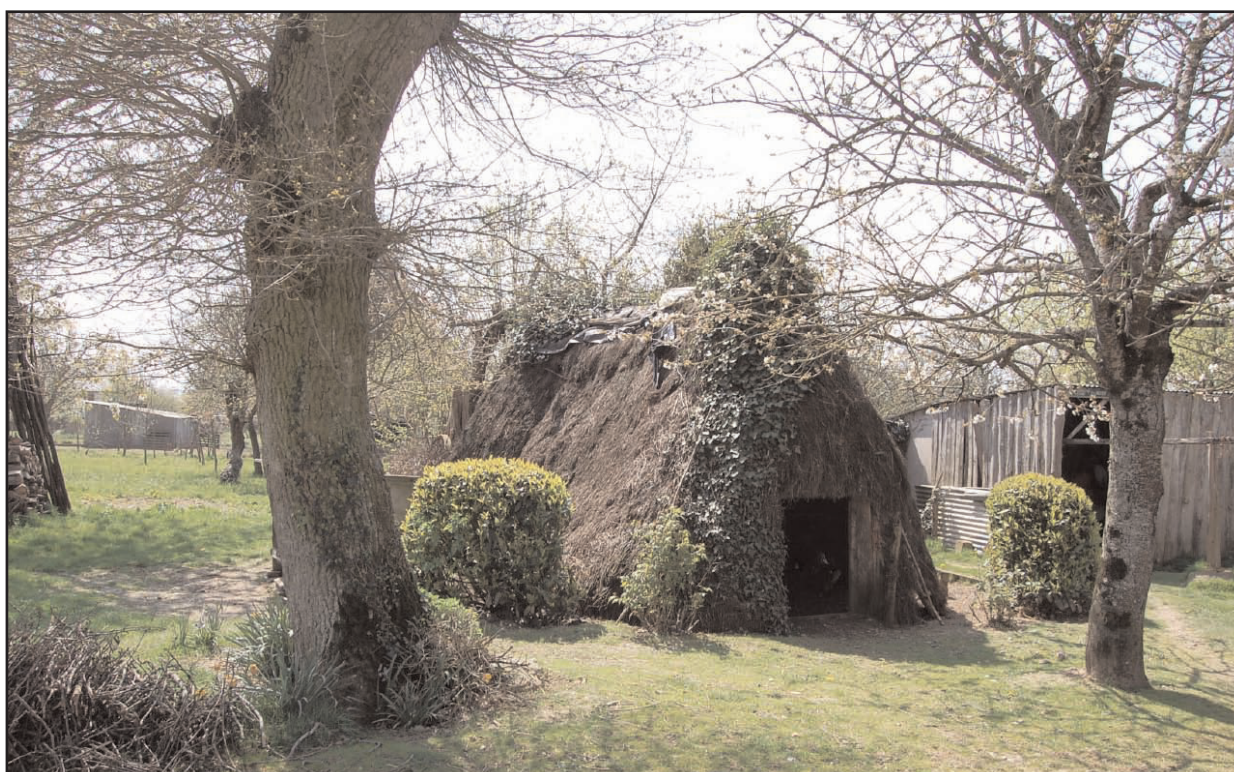
Fig. 52 : Lanouée (56), le Quéstel, loge à sol excavé et poteaux plantés, début XXe s.
