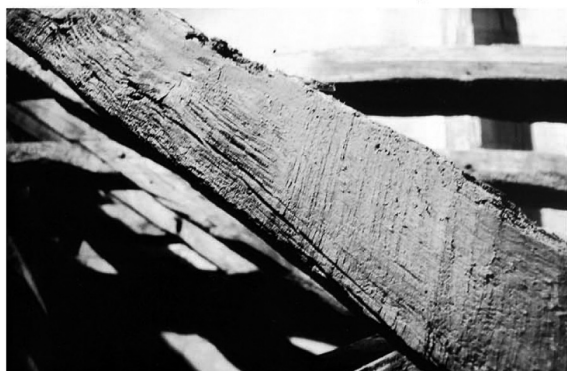
Figure 4 : Axe longitudinal laissé par l'utilisation d'une scie de long (flèches en haut) et traces de scie sur le flanc d'un bois tors (bas). Cathédrale de Bayeux, Calvados. Vers 1220. (Cliché F. E.)
