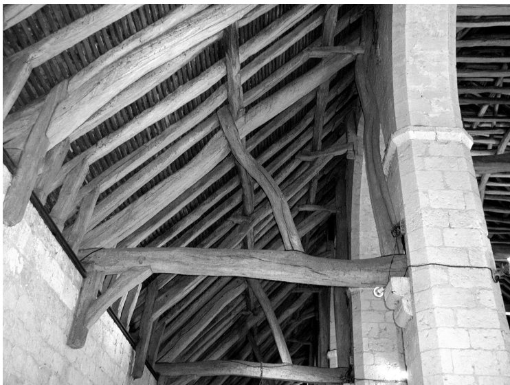
Figure 9: Adaptation des structures de bois aux maçonneries. Grange de la Léproserie Saint-Lazare, Beauvais, Oise. Vers 1210-1215 (cliché Y. LD.)
