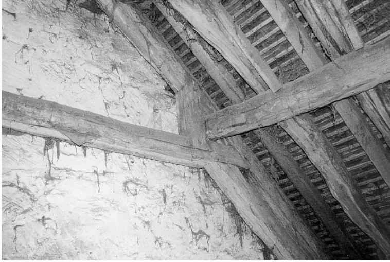
Fig. 7 Assemblages de pied d'une ferme principale
