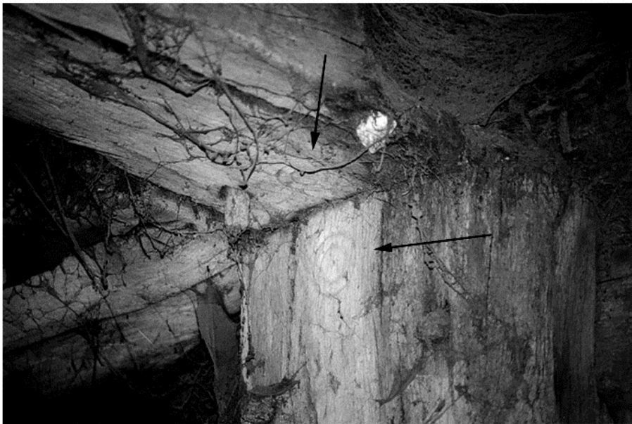
Fig. 13 Marques d'assemblage circulaires ⊙ en tête d'un poteau
