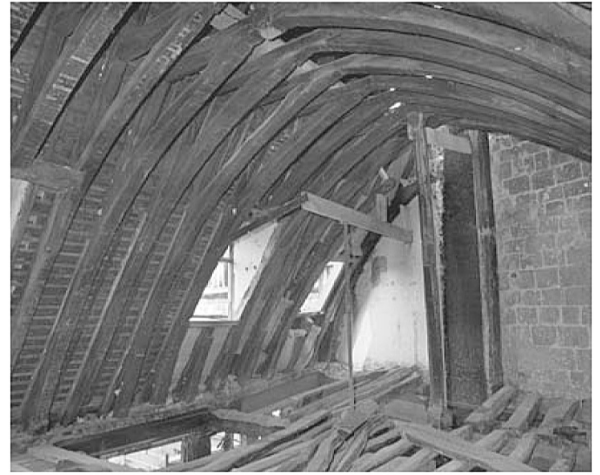
Fig. 7 > Charpente du comble, versant sud (Cl. C. Kollman © 1984, IPRHN).
