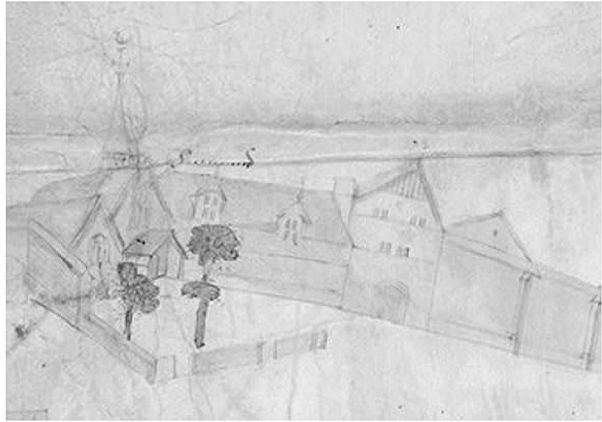
Fig. 12 > Vue de l'église abbatiale, à gauche, et de l'entrée de l'abbaye au centre, surmontée d'un pignon en pan de bois. À droite, un second pignon surmonte le mur d'enclos, correspondant probablement à la toiture couvrant l'escalier à vis et les latrines du bâtiment ( Livre des Fontaines de Jacques Le Lieur, 1525 – Bibliothèque municipale de Rouen, ms. nouv. acq. 742).
