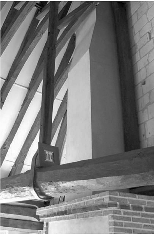
Fig. 13 > Charpente à chevrons-formant-fermes du comble (Cl. F. Épaul).
