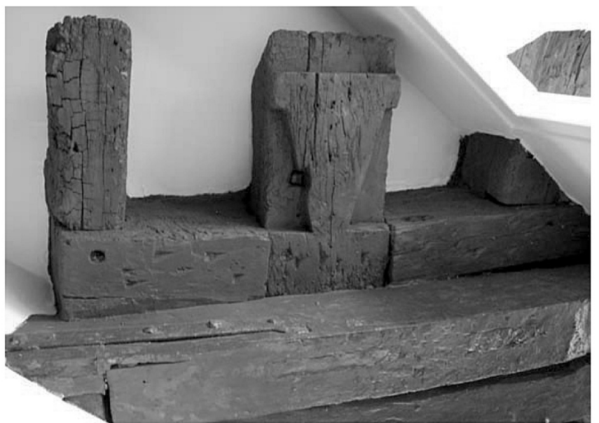
Fig. 16 > Sous-face d'un entrait avec son assemblage en queue d'aronde pour la sablière du pan de bois nord disparu (Cl. F. Épaud).
