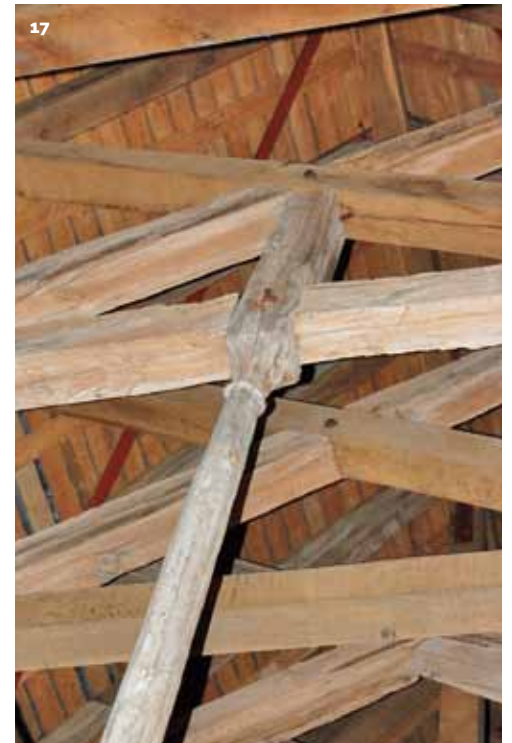
Fig. 13 – Débord de la sablière interne sur des corbeaux, cl. Frédéric Épaud.
