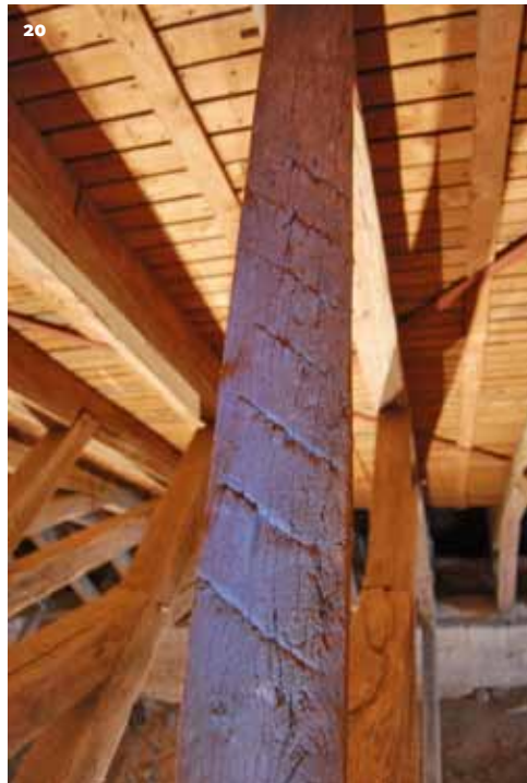
Fig. 18 – Marque à encoches (9 demi-lunes) de F20 du bras nord, cl. Frédéric Épaul.
