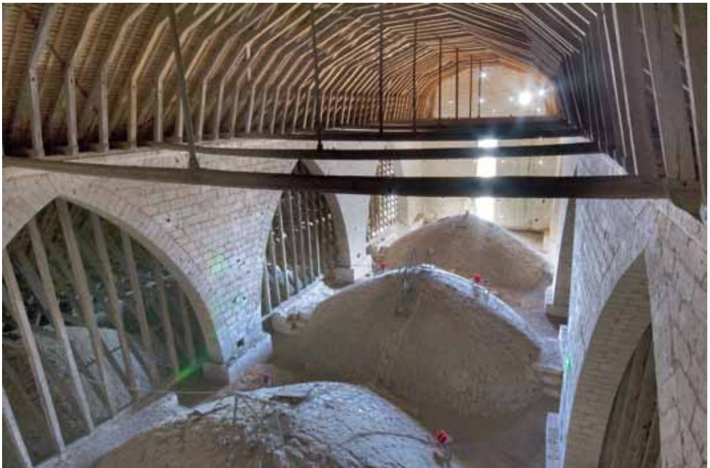
Fig. 22 – Charpente du chevet, vue depuis la tour
