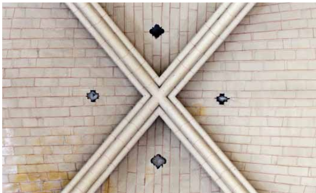
Fig. 8 – Voûte de la travée collatérale VII (chevet), au nord, cl. Éva Michaud-Avril / CESC.M.
