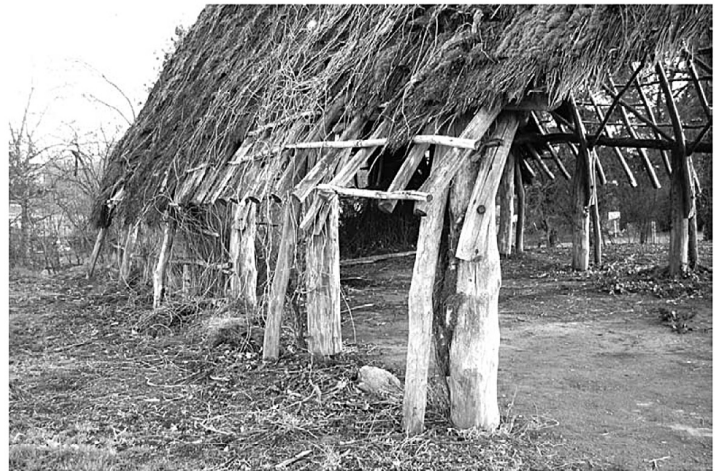
Fig. 44 Vihiers, « La Dauphinerie ». Poteaux plantés contrebutés (cl. F. É.).
