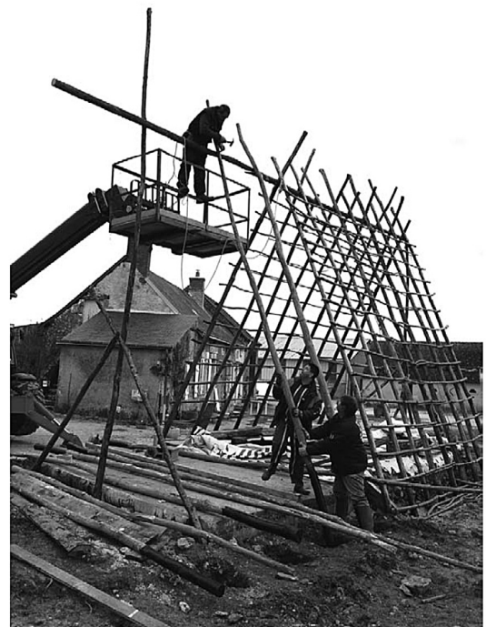
Fig. 12 Saint-Laurent-du-Lin, «La croix du Chêne pilé». Reconstitution d'une loge. Une perche faîtière, clouée provisoirement à deux poteaux, sert à la mise en place des chevrons (cl. F. É.).
