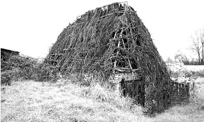
Fig. 16 Cléré-les-Pins, « La croix patée ». Loge sur cave semi-excavée (cl. F. É.).
