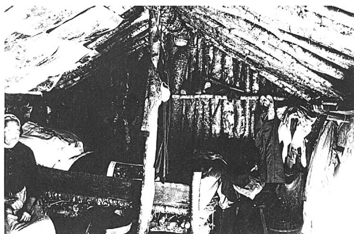
Fig. 2 Forêt de Château-la-Vallière, Indre-et-Loire, intérieur d'une loge avec vue de poteaux faîtières, début XX e siècle (cl. Serv. rég. Inu. Centre).
