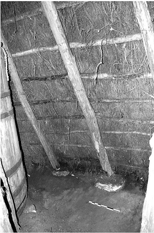
Fig. 31 Ambillou, « La Giberdière ». Pieds des chevrons de la croupe, en appui sur des pierres plates (cl. F. É.).
