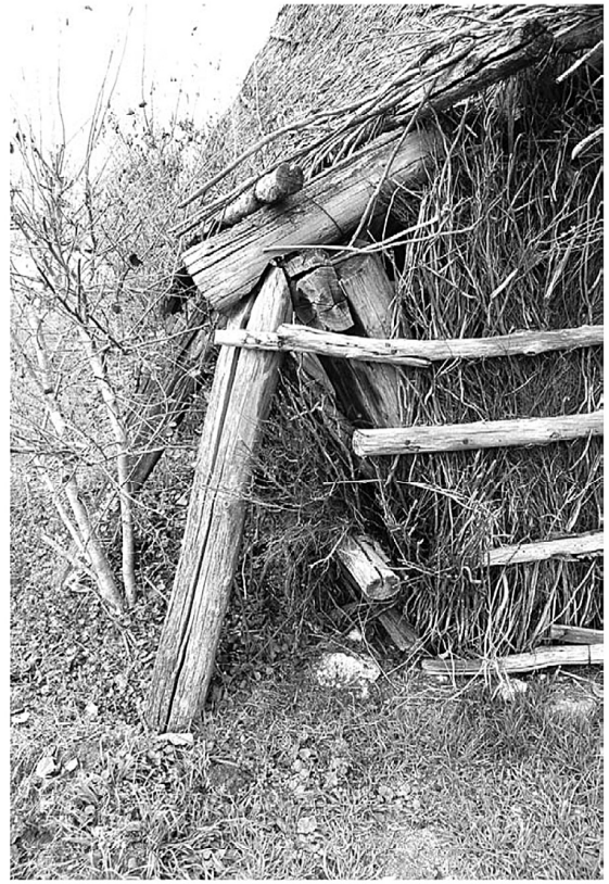
Fig. 32 Ambillou, « La Giberdière ». Poteau oblique de soutien (cl. F. É.).
