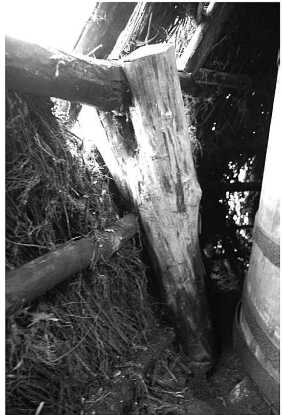
Fig. 27 Ambillou, « La Giberdière ». Poteau planté à fourche (cl. F. É.).
