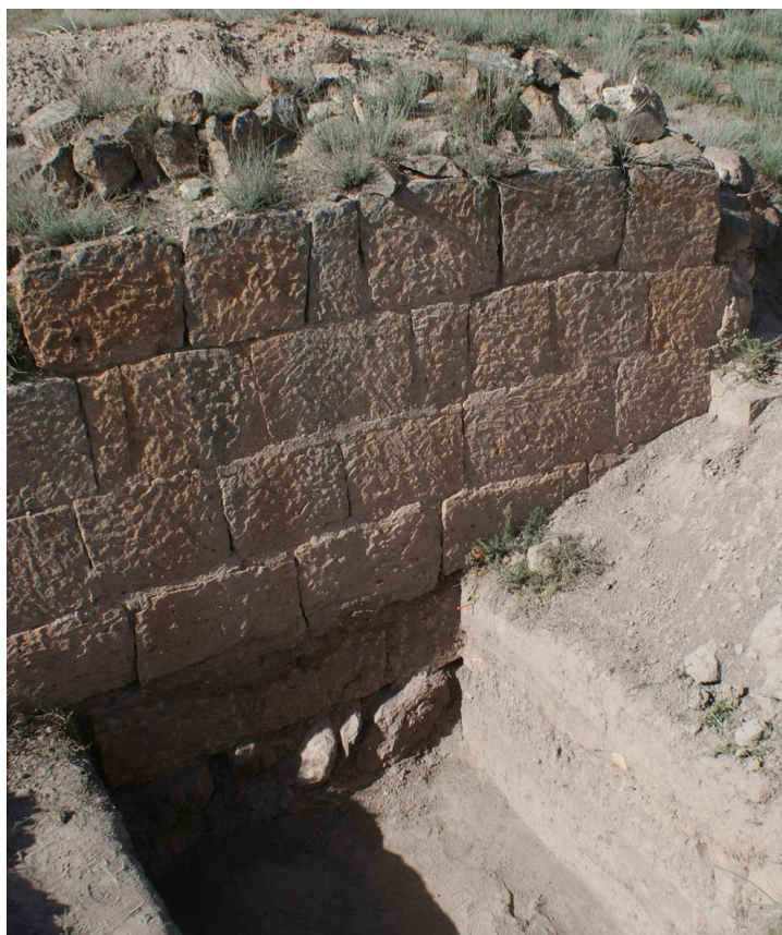
Fig. 130 – Ereruyk. Parement sud du mur intermédiaire du « barrage » et ses fondations mises au jour par le sondage SD 13 de 2014. Photo de C. Jorda (LA3M, 2014).
