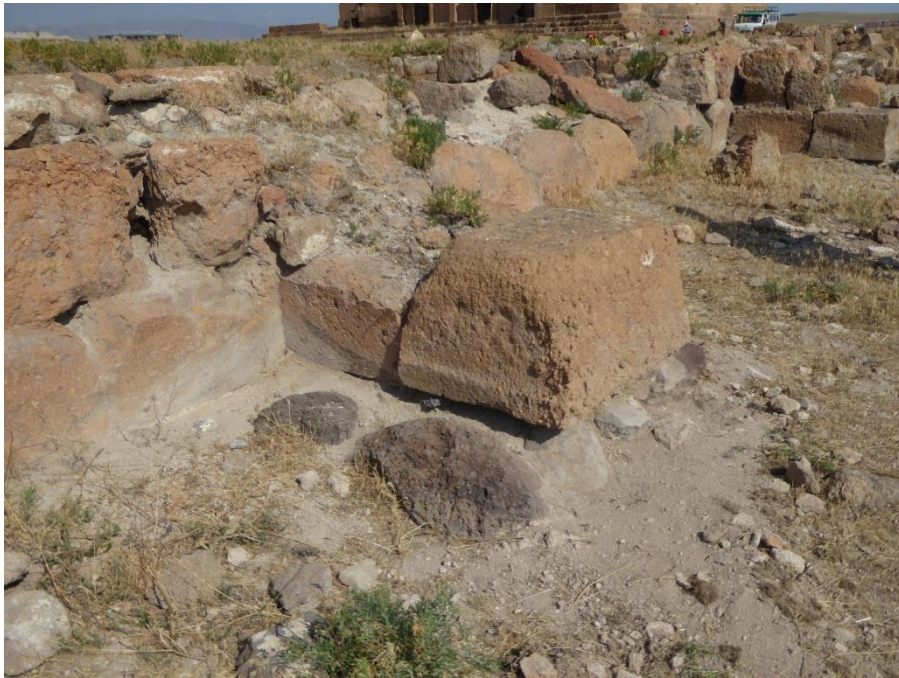
Fig. 32 – Ereruyk. « Enceinte » orientale. Saillant SAL 1710, vue du sud-est. Photo d'A. Hartmann-Virnich (LA3M, 2015).
