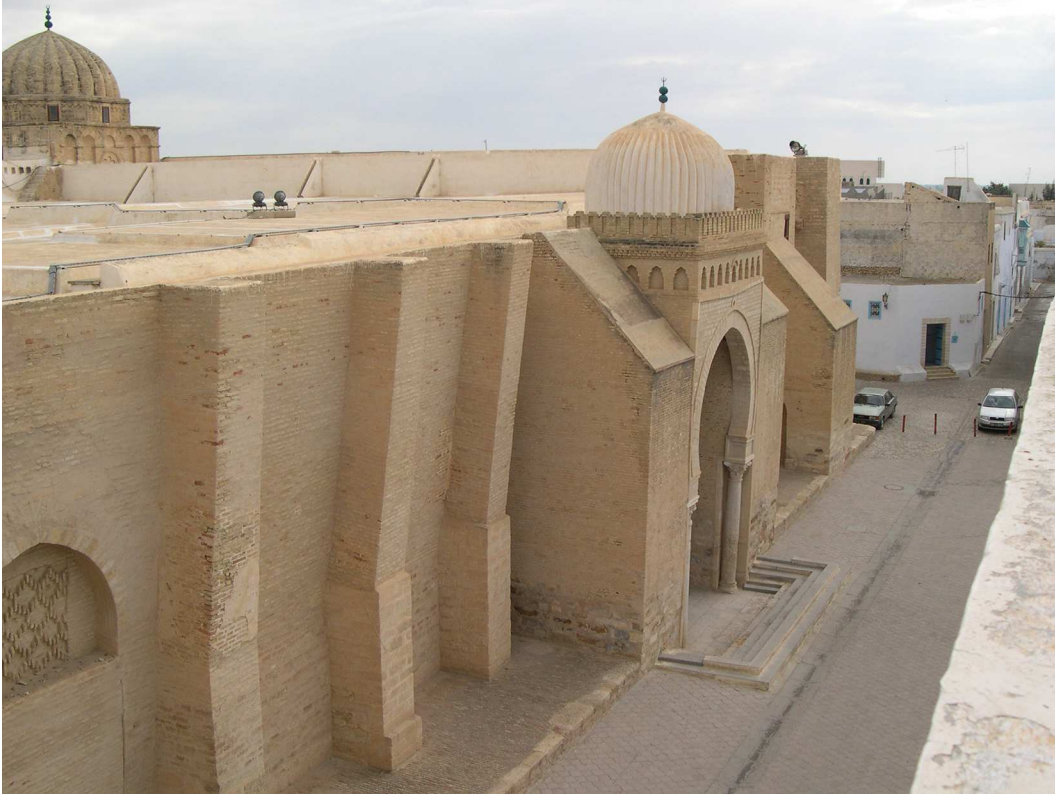
Figure 2. Kairouan. Depuis que les souks qui l'entouraient ont été détruits, la grande mosquée présente pour toute façade une série irrégulière de contreforts. Photo de l'auteur, mars 2004.
