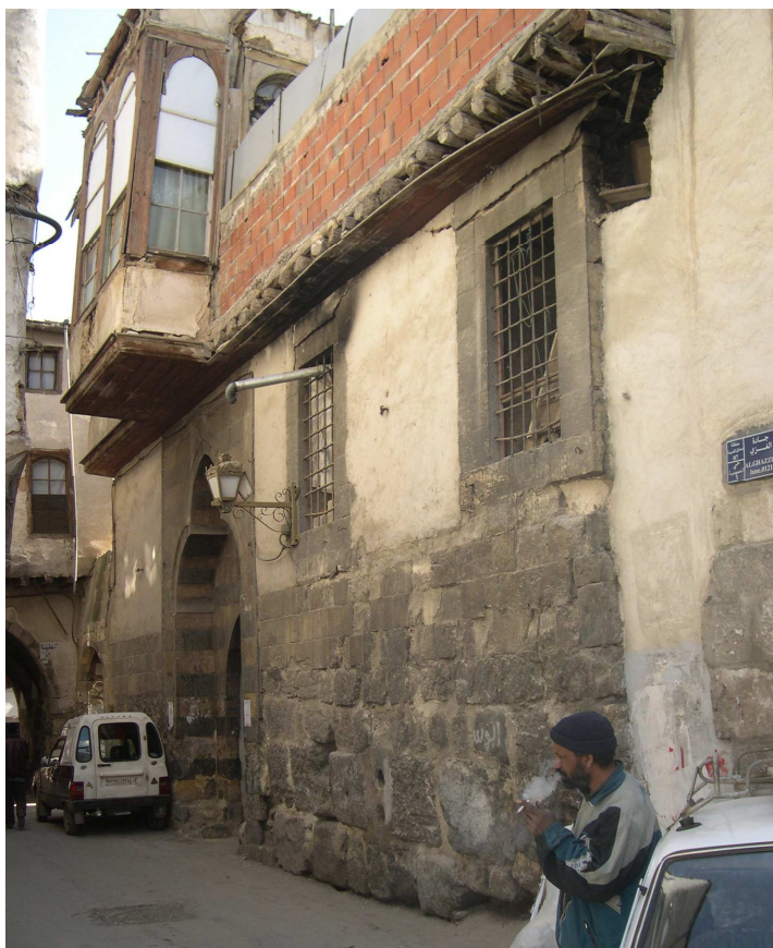
Figure 1. Damas. Mur de la période antique qui constitue le soubassement d'une mosquée de la période mamelouke, lui-même surélevé au cours de la période ottomane par un oriel construit en bois et en terre. Le garde-corps qui couronne la mosquée est en brique et surmonté de panneaux de tôles. Photo de l'auteur, fév. 2004.
