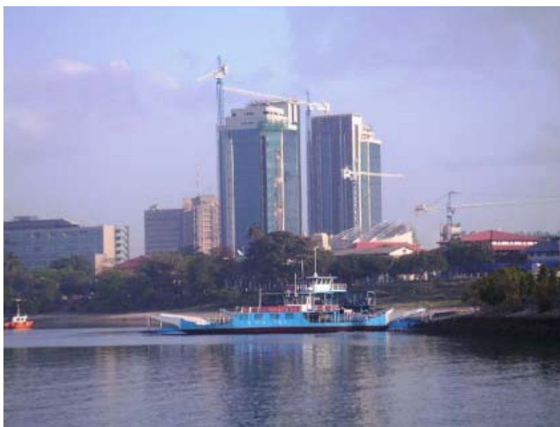
Les deux tours de la Banque centrale de Tanzanie en construction Dar es Salaam, 2005
