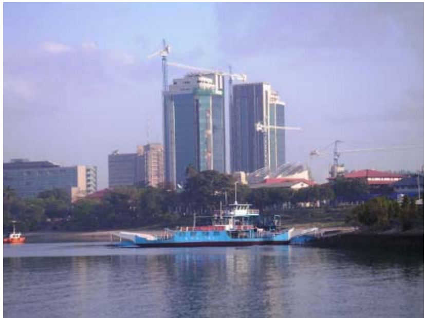
Les deux tours de la Banque centrale de Tanzanie en construction Dar es Salaam, 2005
