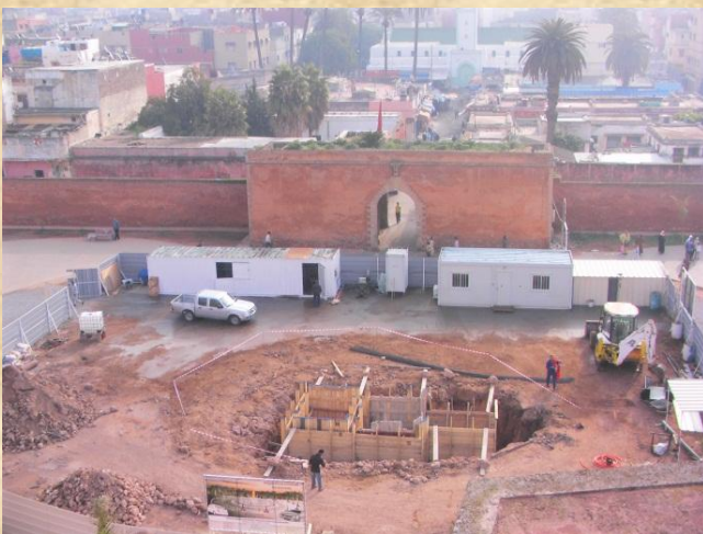
Photo 11 : Travaux de fondation de la fontaine. (© Souad Azizi, 6 novembre 2010)
