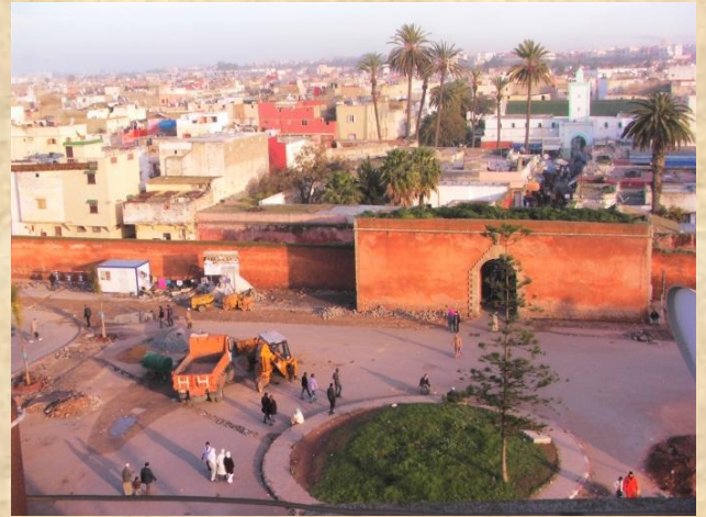
Photo 8 : Travaux de transformation du rond-point (© Souad Azizi, 17 janvier 2010).
