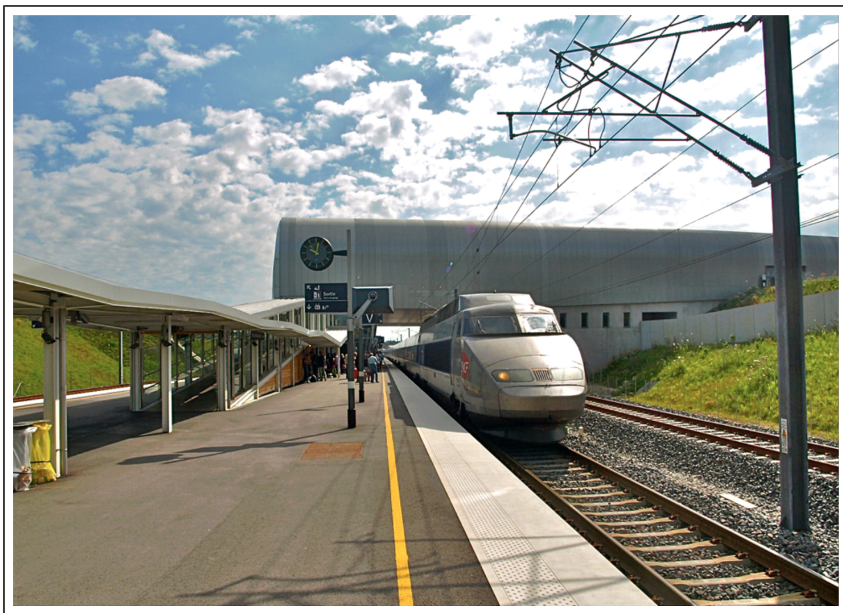
Fig 19 : Train à grande vitesse entrant en gare de « Belfort-Montbéliard TGV » (Richer, 2012)
