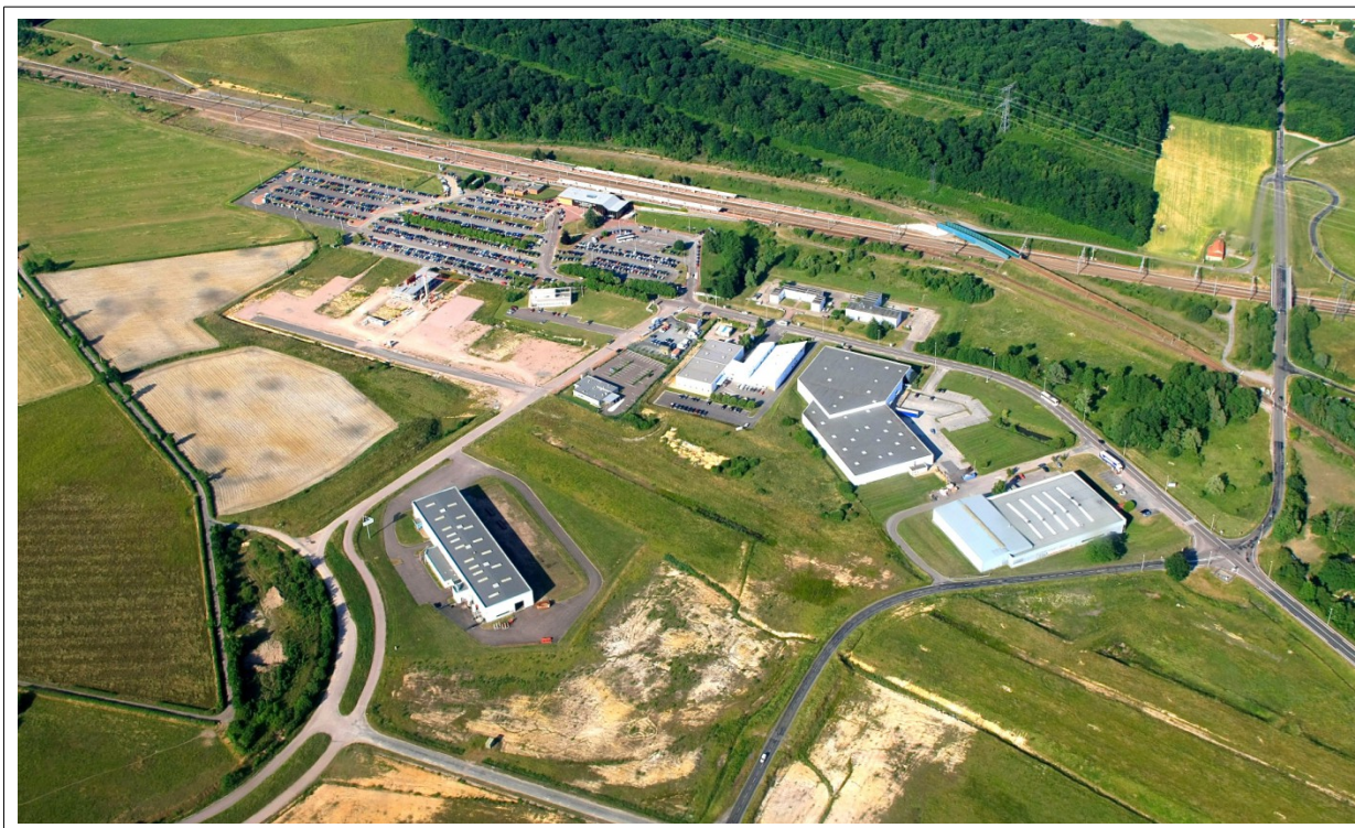
Fig. 14 : Un environnement encore peu dense autour de la gare Le Creusot TGV, 30 ans après son ouverture (2012) source : www.simplantersudbourgogne.org
