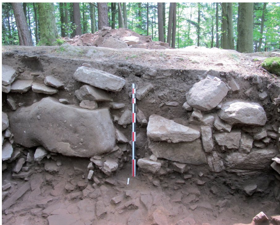
Fig. 16 : Vue du parement dégagé dans le sondage 1' Photo : C. Féliu
