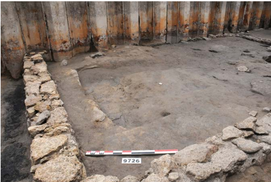
■ Fig. 55 : Vue depuis le sud-ouest, de la maison en construction (UNF143) de la phase 1S, avec des amas de terres de nature différente (limon, argile, terre malaxée) liées au chantier.
