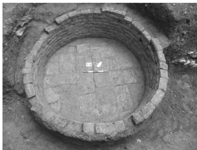
Fig. 13. Vasca settecentesca per la produzione del grassello di calce.
