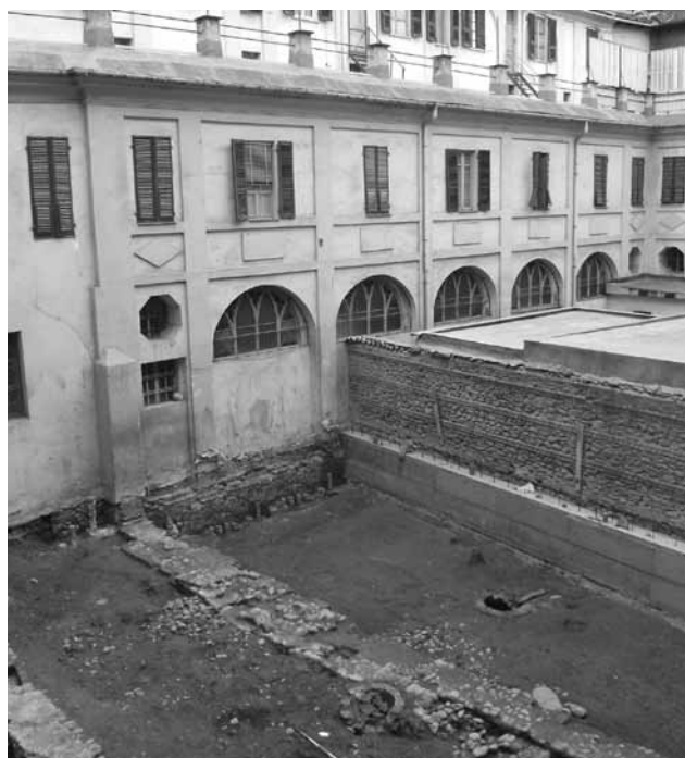
Fig. 2. Il chiostro di S. Domenico e le murature della manica occidentale in corso di scavo.
