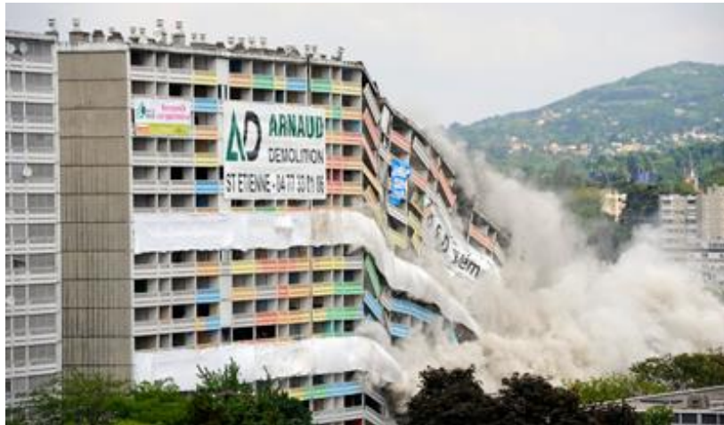
Fig.4 : Démolition à l'explosif avec communication en façade
