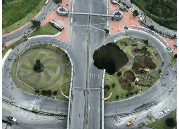
Figura 2 – Vista aérea del hundimiento «El Trébol»
