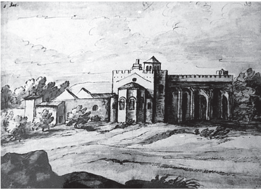
Fig. 3 – Vue de l'église du nord-est avant la suppression de la nef en 1763. Dessin de l'album de la collection de Laincel. Musée Calvet, Estampes, fol. 36 (fol. 81, p. 63, dessin n° 39).
