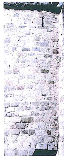
tour d'angle côté sud
