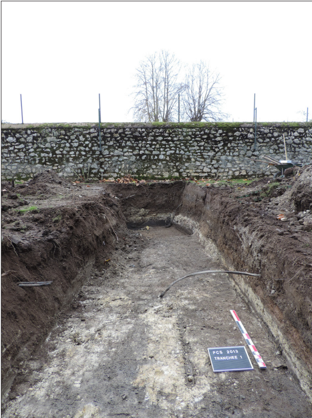
Photo 17 : la tranchée T1, partie ouest (au fond, mur moderne qui sera abattu dans le cadre du projet de jardin)
