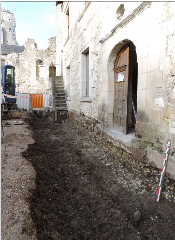
Photo 4 : la tranchée pour l'installation des réseaux et du drain devant la façade ouest du logis du prieur, après la réalisation des sondages n°61 et 62 (la maçonnerie apparente le long de la façade est un drain de la seconde moitié du 20 e siècle)
