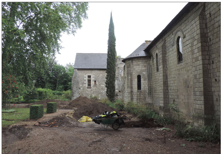
Photo 5 : les sondages le long de la façade nord du réfectoire ; au premier plan, le sondage n°64
