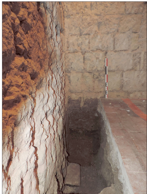
Photo 33 : le sondage n°68, dans l'angle sud-est du logis du prieur (rez-de-chaussée (vue vers le sud))
