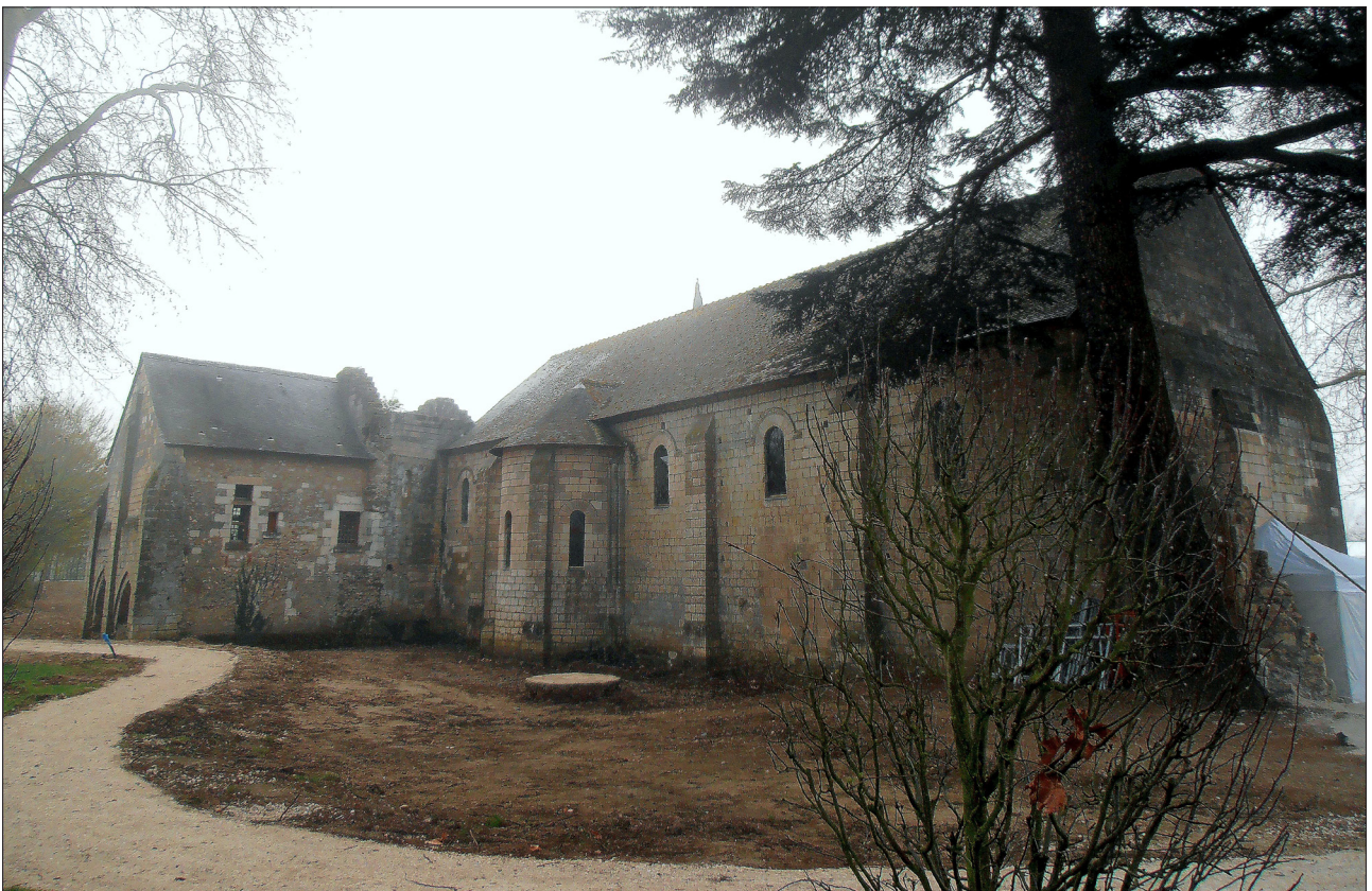
Photo 7 : le reprofilage du terrain devant la façade nord du réfectoire permet maintenant d'en apprécier toute l'ampleur (mars 2014)
