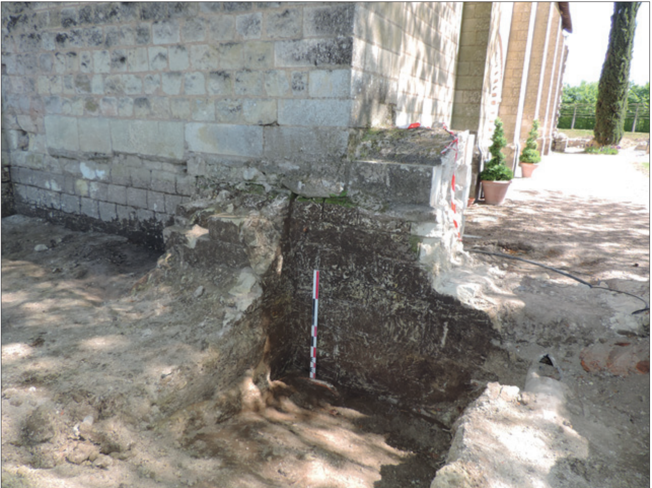
Photo 25 : angle sud-ouest du réfectoire. On voit la base du contrefort sud-ouest du réfectoire, et, devant, la fondation du pignon de l'aile des convers (M511). On note aussi la continuité du mur gouttereau oriental de cette aile avec le pignon du réfectoire, signe que ce mur est antérieur au bâtiment, qui s'est greffé dessus
