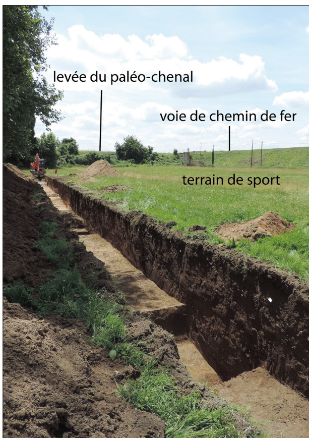
Photo 9 : ouverture de la tranchée du sondage n°66, dans le terrain de sport au sud-ouest du prieuré
