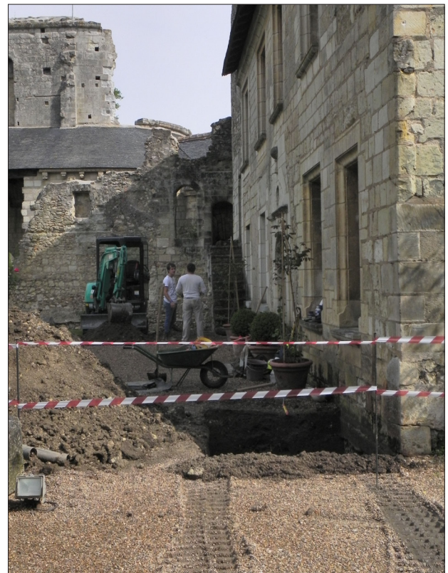
Photo 3 : le sondage n°61 à l'angle sud-ouest du logis du prieur
