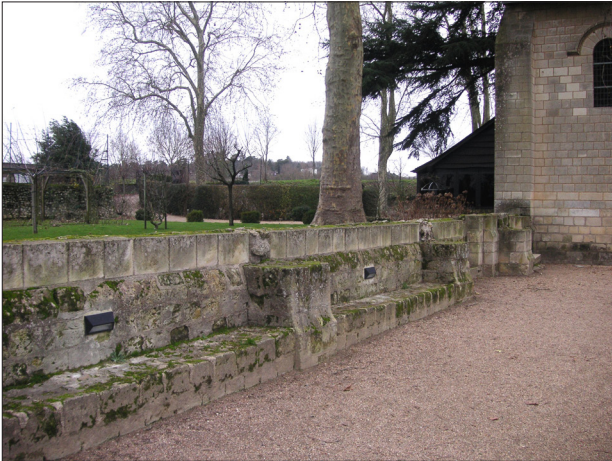
Photo 13 : l'extrémité nord du gouttereau oriental de l'aile des convers, très restauré au 20 e siècle
