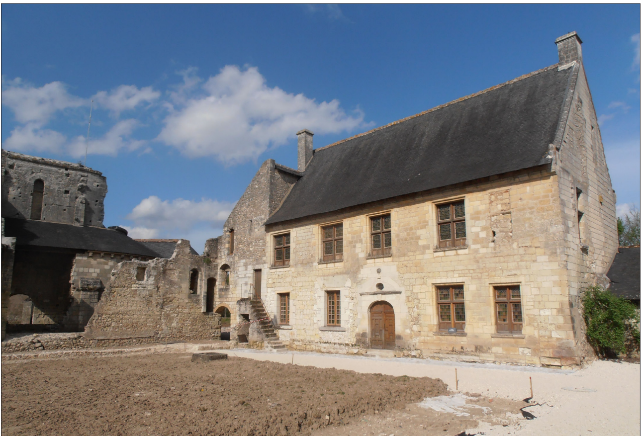
Photo 31 : façade ouest du logis du prieur, avec les ruines du logis du sacristain et le chœur de l'église (à gauche). État en mars 2014
