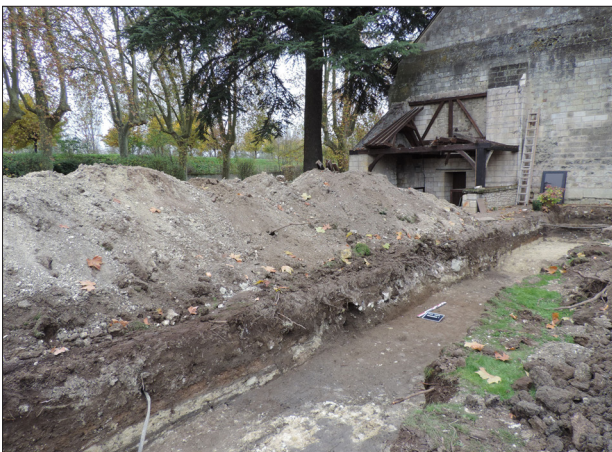
Photo 15 : la tranchée T1, partie est
