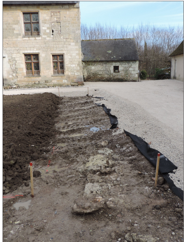
Photo 36 : le mur sud du clos du prieur (M22), apparu lors des travaux de terrassement pour le nouveau jardin. Entre la terre végétale et la grave se trouve l'emplacement de la future pergola, inspirée de la réalité archéologique. Elle est légèrement décalée vers le sud pour éviter qu'elle ne soit fondée sur les vestiges (février 2014)
