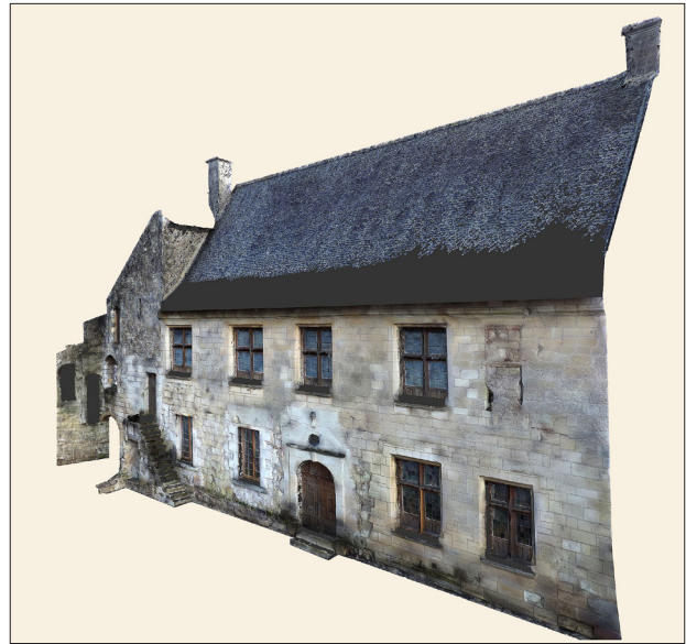
Photo 35 : restitution de la façade ouest du logis par photogrammétrie 3D (Matthieu Gaultier, Sadil, 2014)
