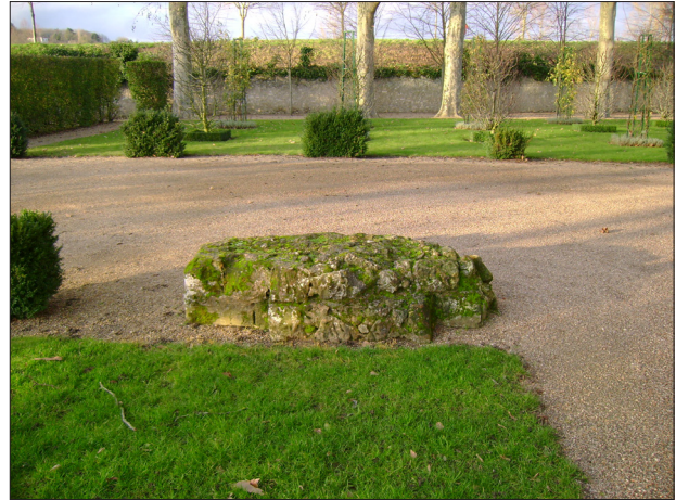
Photo 14 : l'angle nord-ouest de l'aile des convers, un moignon de maçonnerie dépassant du sol du jardin (vue vers le nord)
