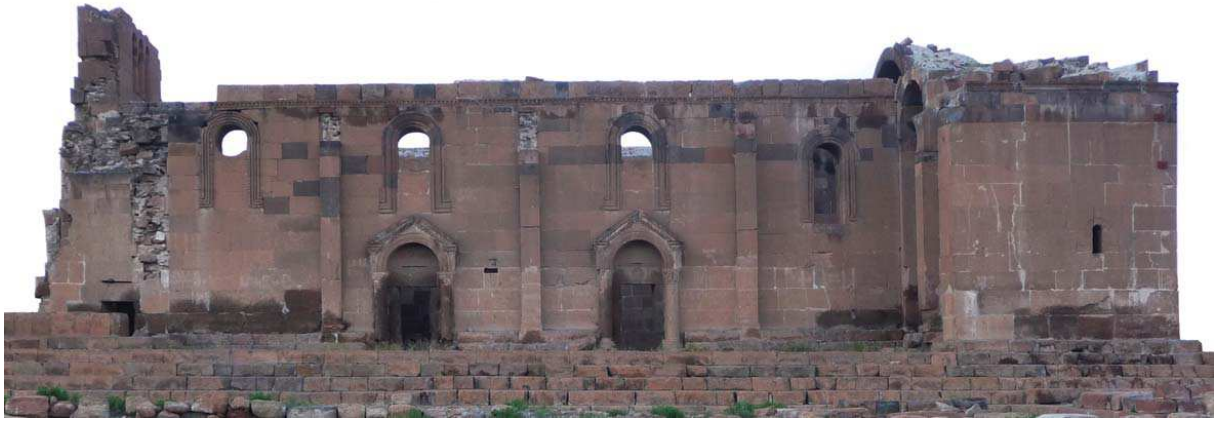
Fig. 23 – Ereruyk. Basilique, façade sud. Cliché : A. Hartmann-Virnich (LA3M, 2014).
