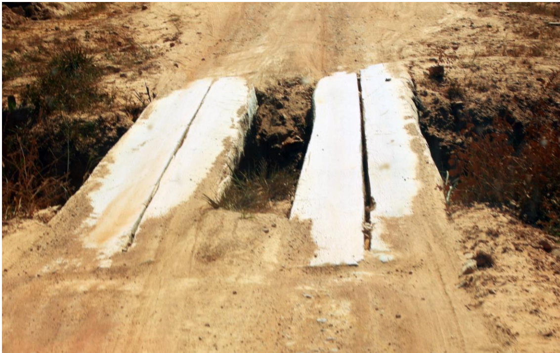
Figure 6 Un pont sur la route entre Alta Floresta et Cotriguaçu
