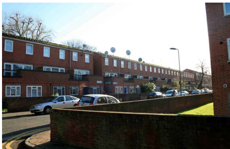
Figure 20 : Stoke Newington : Logement social (photo de l'atelier quartier)
