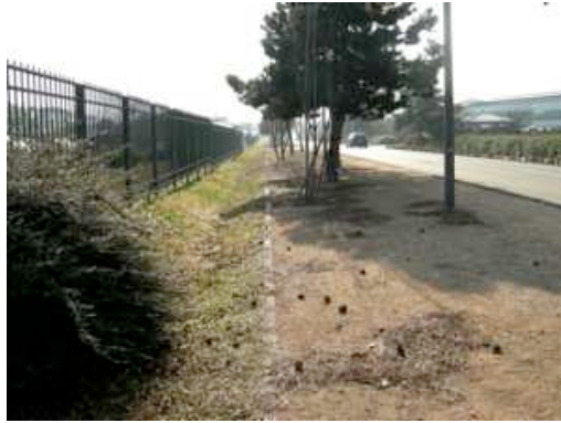
figure 9 : noue, allée Irène Joliot-Curie, parc technologique (2011)
