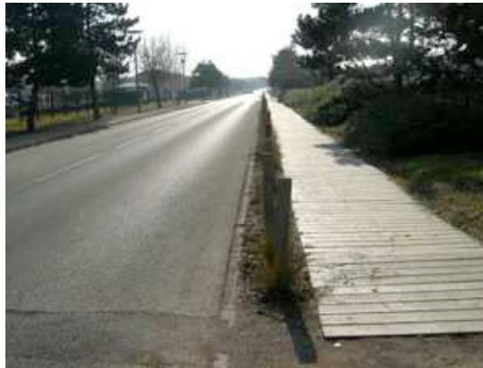
figure 10 : noue, allée Irène Joliot-Curie, parc technologique (2011) 1
