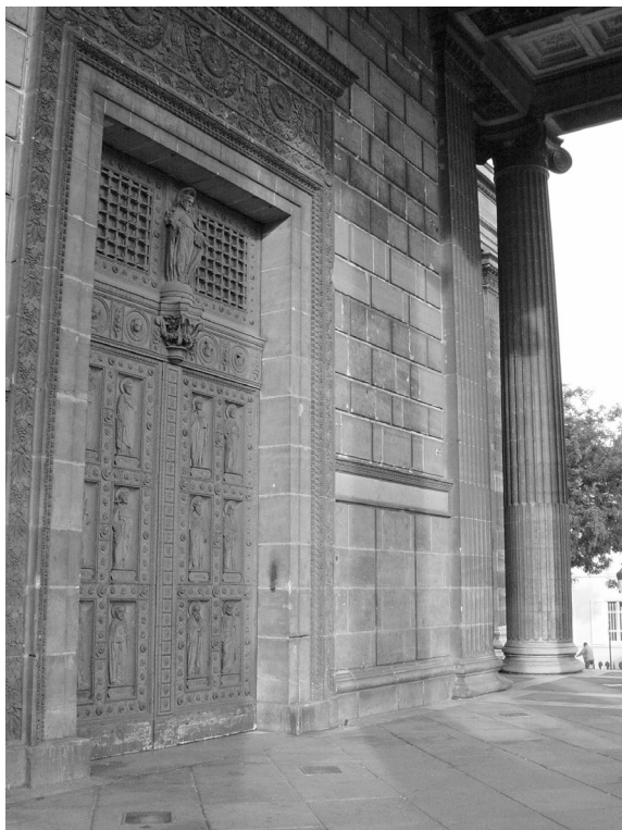
Figure 5. Aspect actuel du mur situé sous le porche de l'église St-Vincent de Paul et qui servait à l'origine de support à des plaques émaillées polychromes (©A. Grand-Clément).
