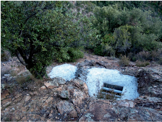
Fig. 7 Puits RD5-5bis après l'opération de mise en sécurité (cl. GEMA).
